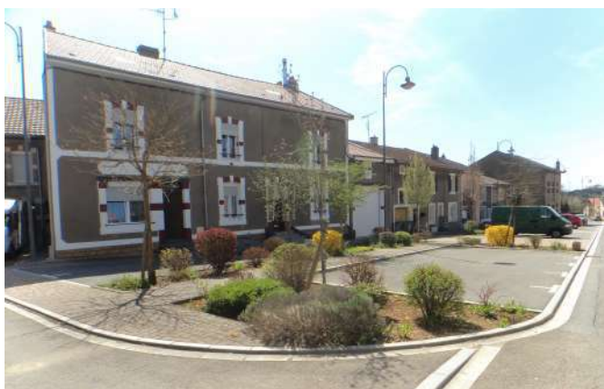
Stationnement avec aménagement paysager rue de Juminel à Montigny
