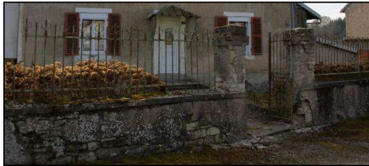
Mur de pierre surmonté d'une grille en fer forgé
