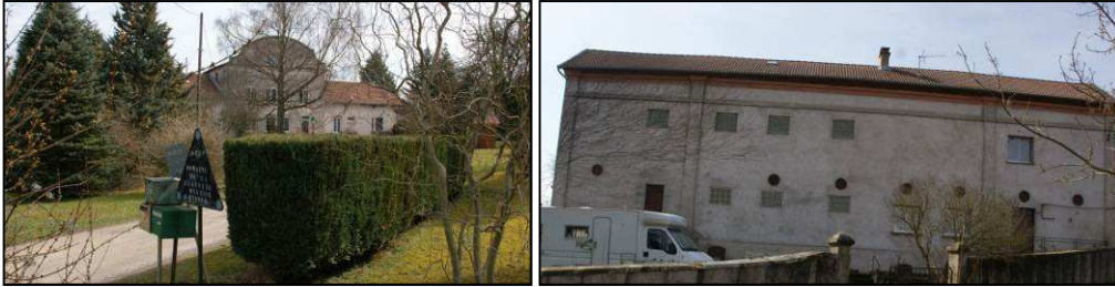
Patrimoine industriel : Ancienne usine de Cérésite et entrepôt du magasin Printemps de Paris
