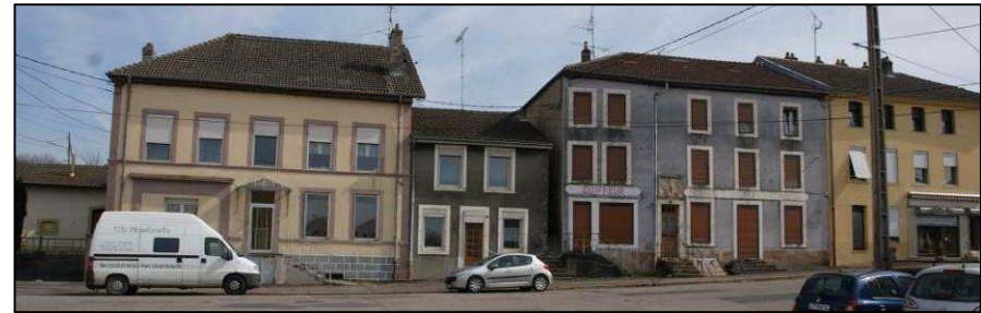
Habitations groupées en alignement au domaine public rue de la Gare
