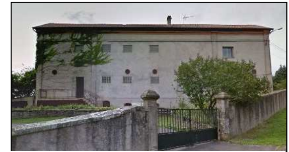
Ancien entrepôt du Magasin du Printemps de Paris transformé en deux logements
