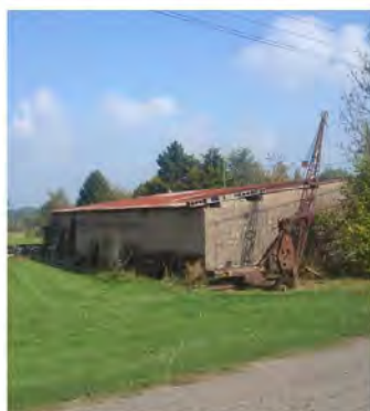
D3 : hangar le long de la Grande Rue
