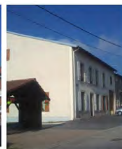
Bâtiment communal comprenant 6 loge- ments
