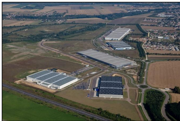
Vue aérienne du Parc Logistique de l'Aube
