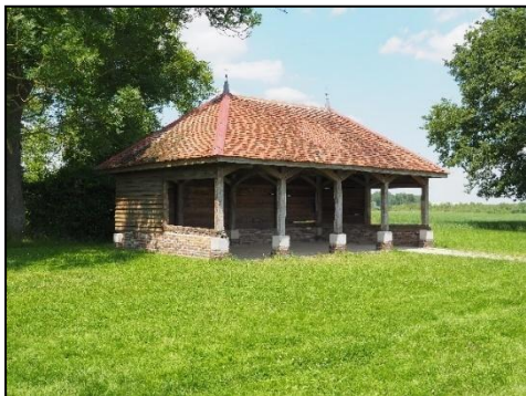
Lavoir terrain de sport, rue du Vazon
