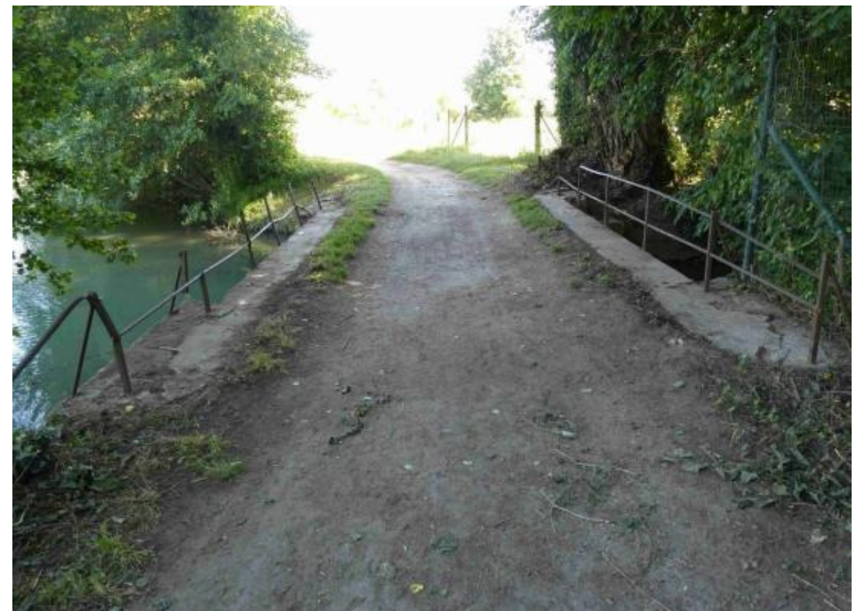
Figure 21 – photo ouvrage V290A (inspection périodique 2022)
