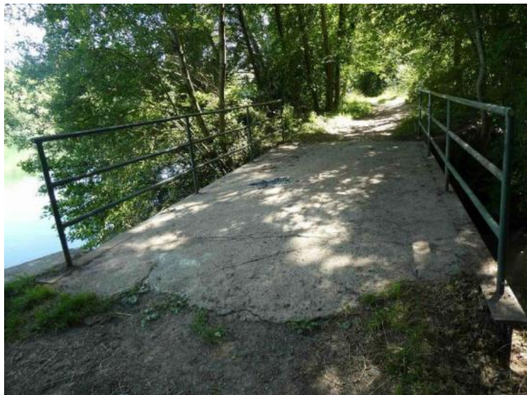
Figure 20 – photo ouvrage V114A (inspection périodique 2022)
