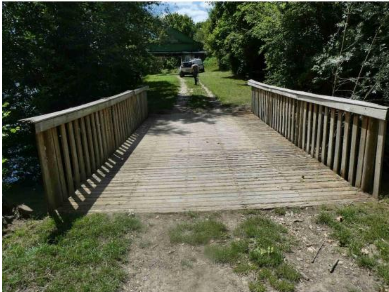
Figure 18 – photo ouvrage V389B (inspection périodique 2022)
