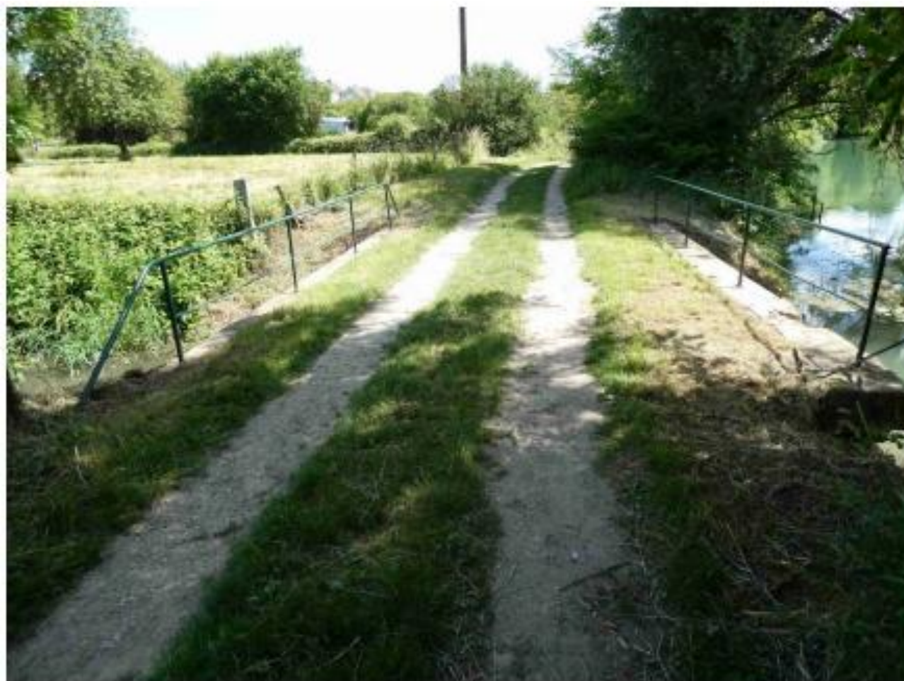
Figure 16 – photo ouvrage V748A (inspection périodique 2022)
