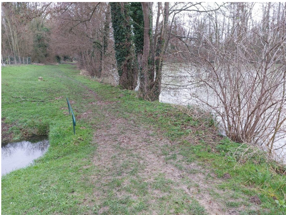
Figure 5 - Exemple de franchissement d'un fossé à MONT SAINT PERE, ouvrage à prolonger
