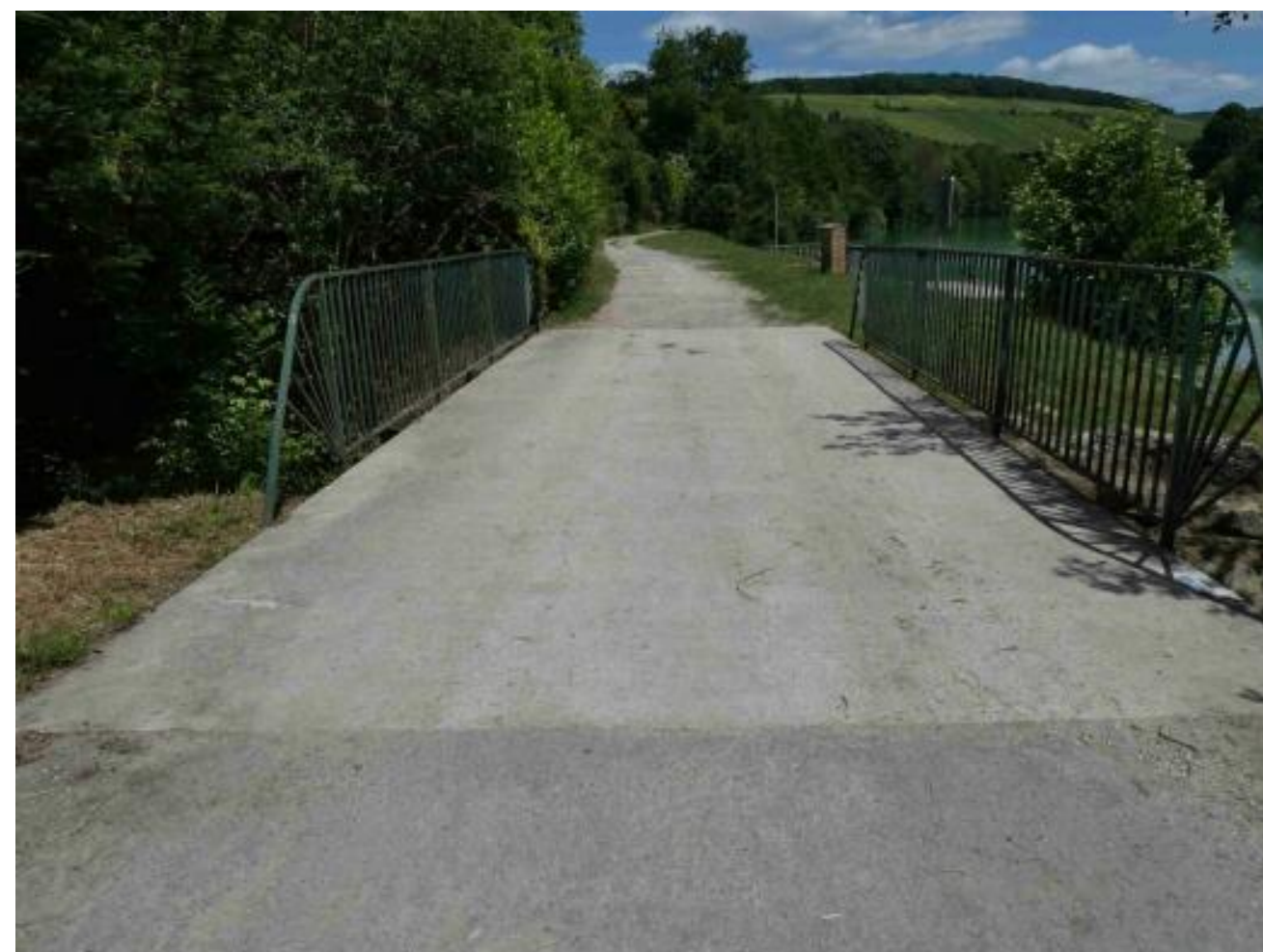
Figure 17 – photo ouvrage V389A (inspection périodique 2022)
