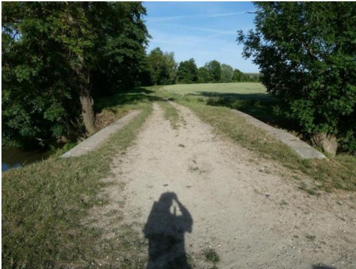
Figure 22 – photo ouvrage V701A (inspection périodique 2022)
