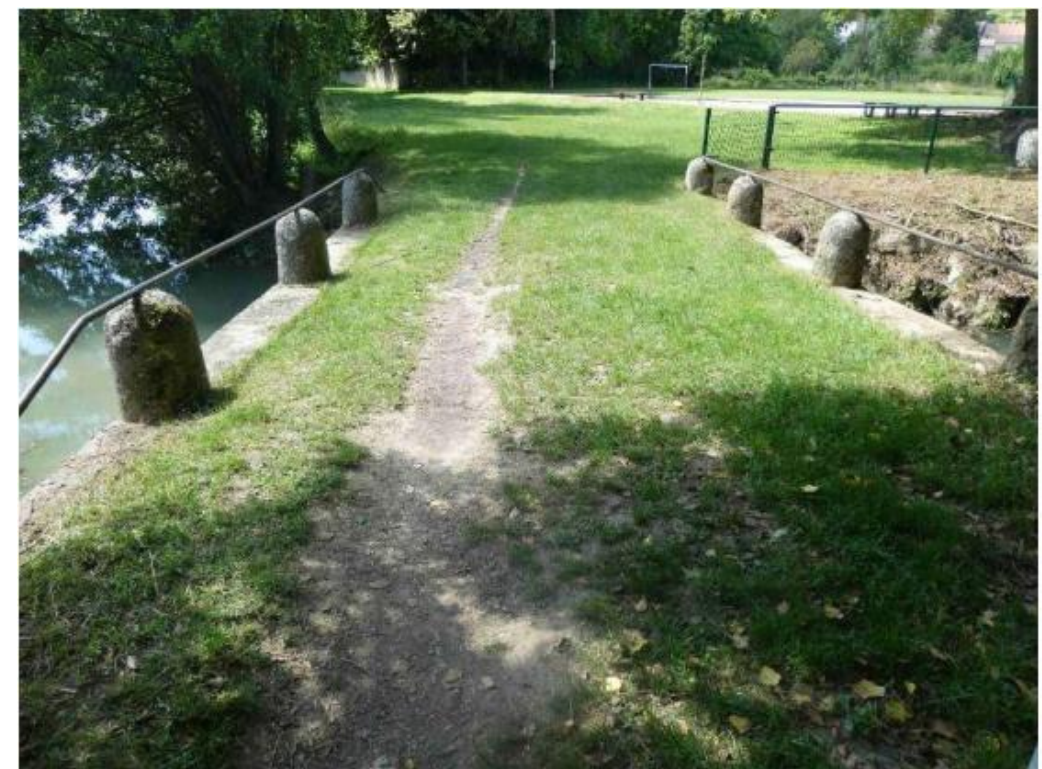
Figure 19 – photo ouvrage V524A (inspection périodique 2022)
