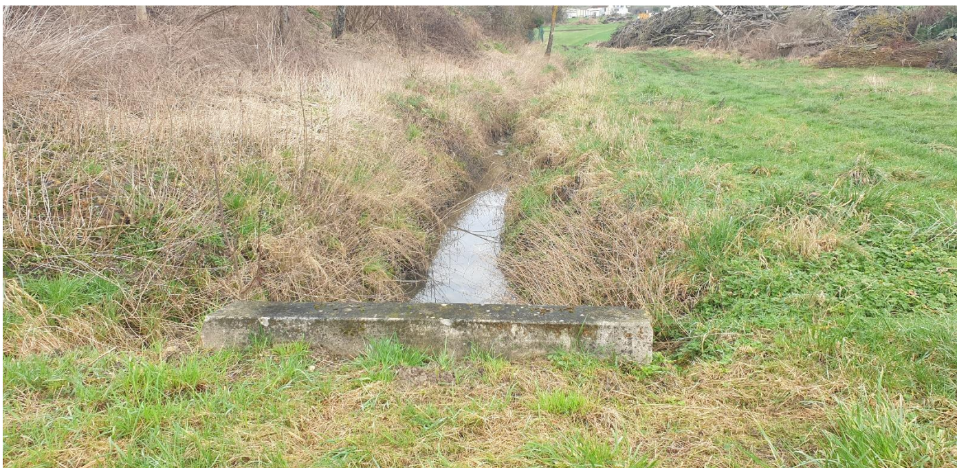
Figure 6 - Exemple de franchissement d'un fossé à PASSY SUR MARNE
