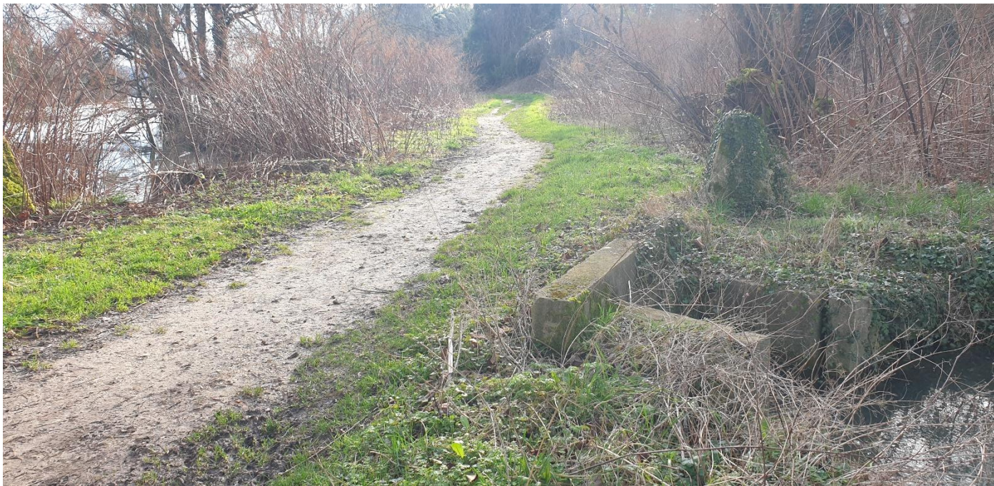
Figure 7 - Exemple de franchissement d'un étang à ESSOMES SUR MARNE
