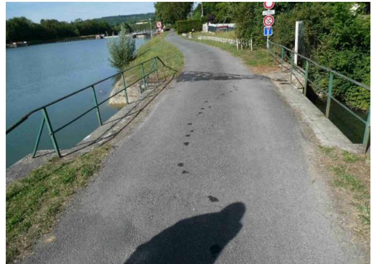
Figure 23 – photo ouvrage V163A (inspection périodique 2022)
