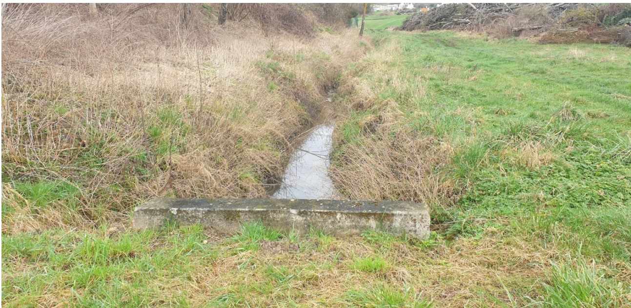
Figure 33 - Exemple de franchissement d'un fossé à PASSY SUR MARNE
