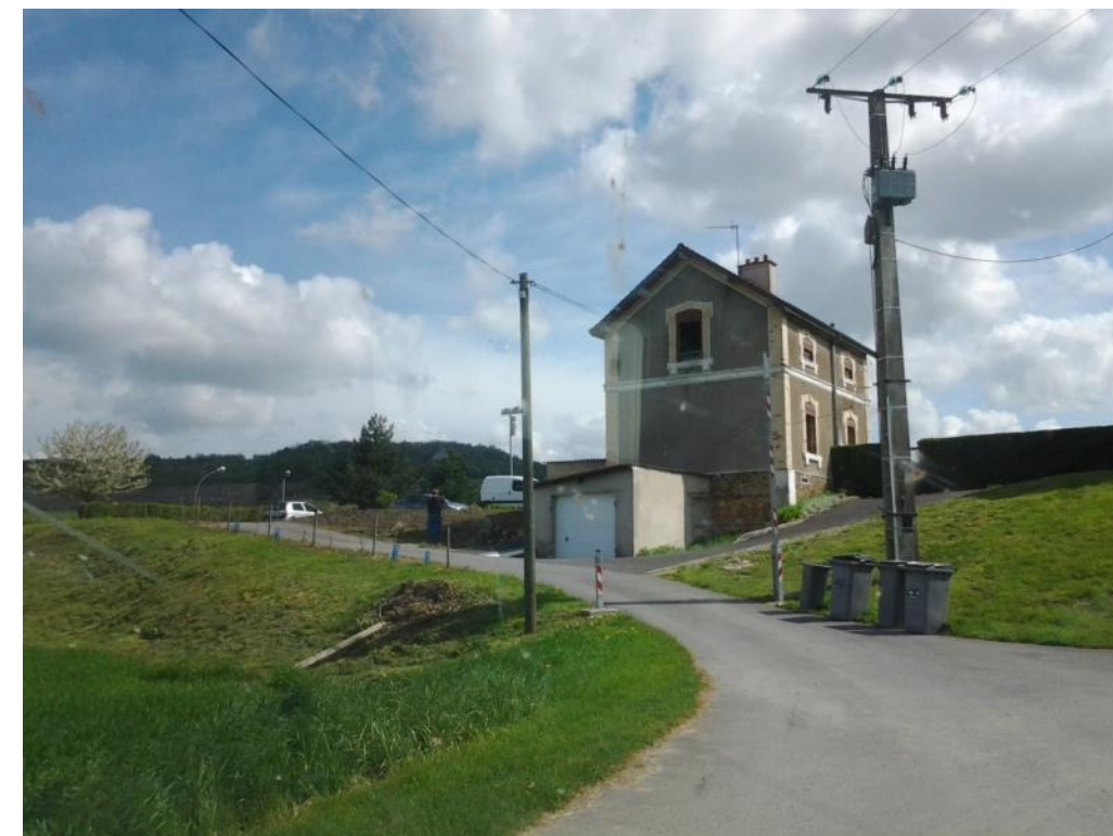
Figure 22 - Courcelles accès maison éclusière VNF
