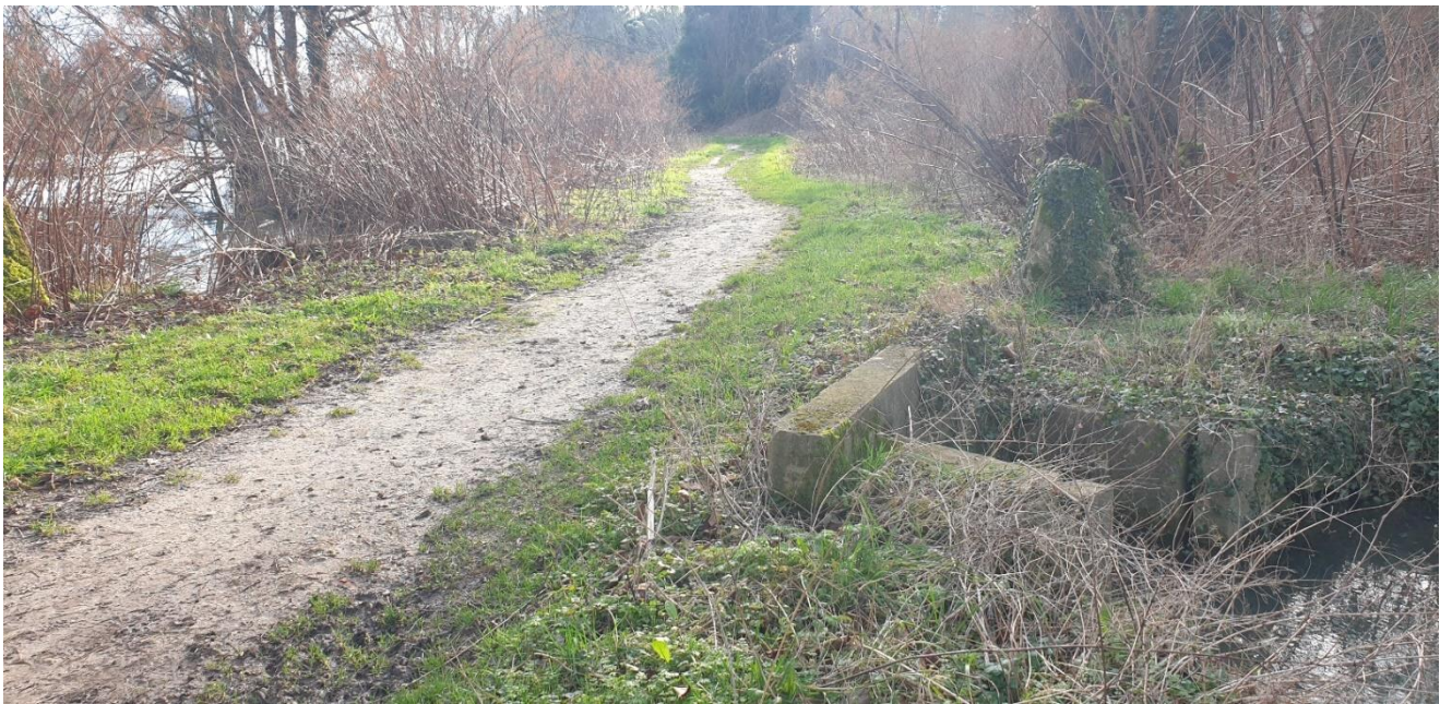
Figure 34 - Exemple de franchissement d'un étang à ESSOMES SUR MARNE
