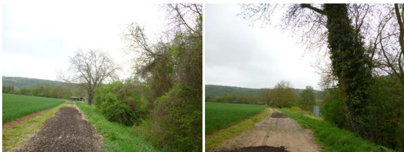
Figure 67 - Exemples de sections faisant l'objet de travaux d'entretien.
