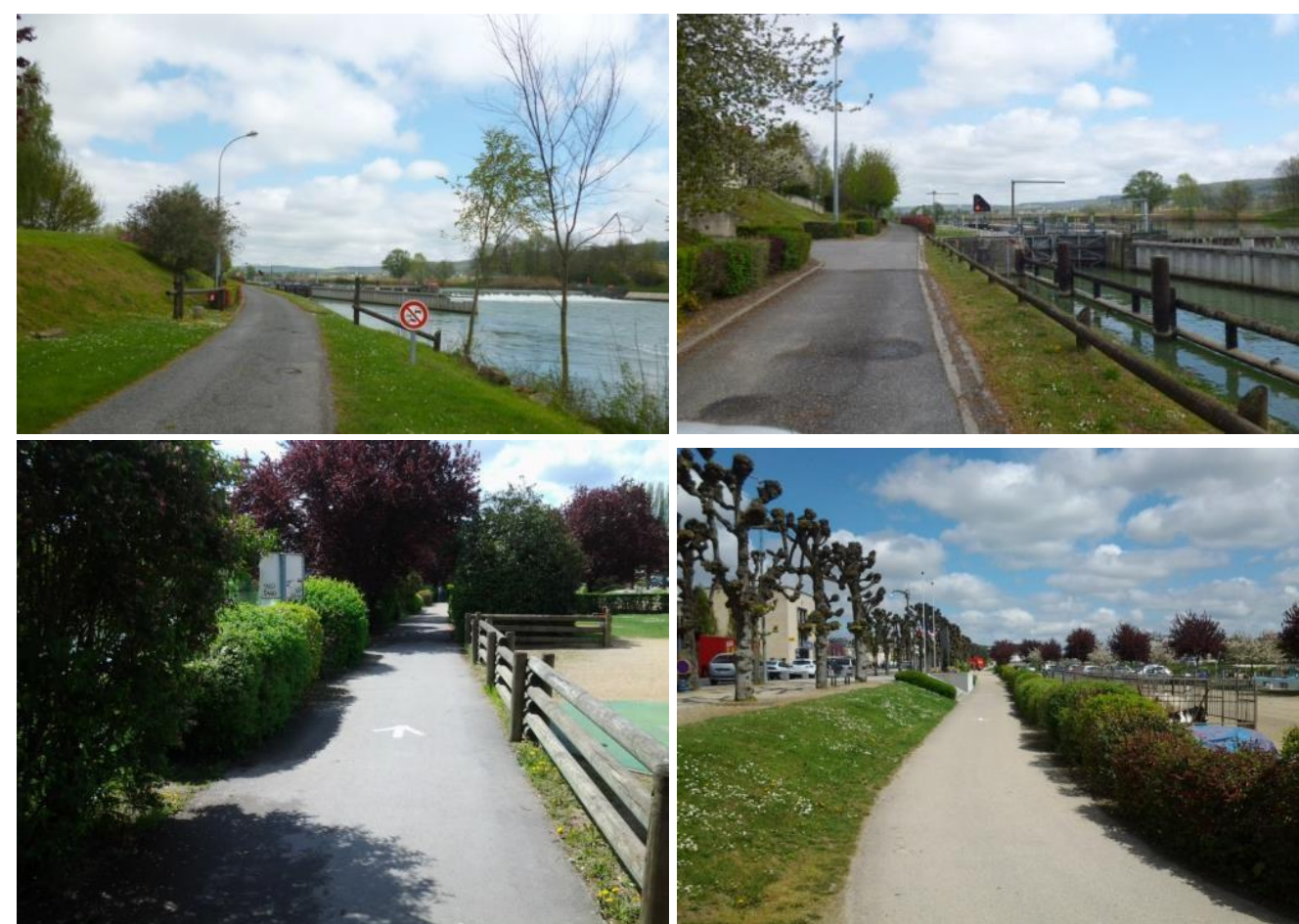
Figure 65 - Exemples de sections déjà revêtues de l'itinéraire.
