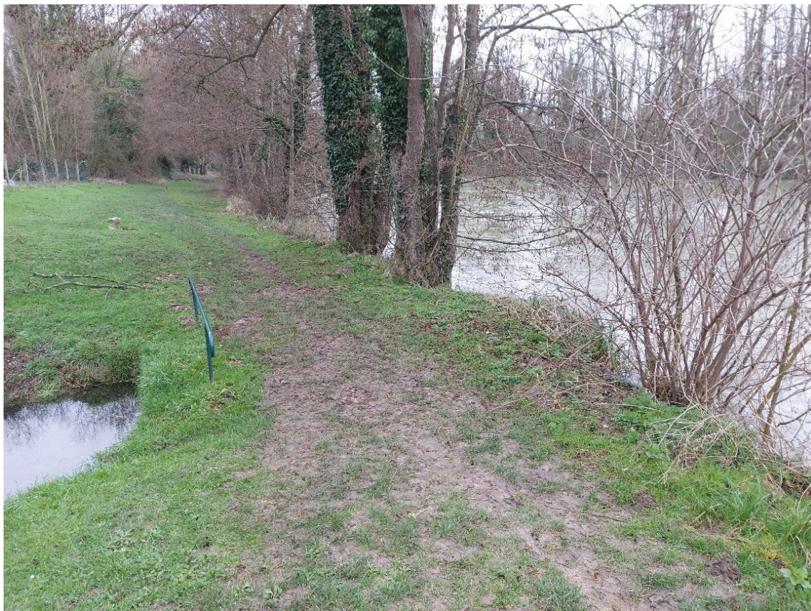
Figure 32 - Exemple de franchissement d'un fossé à MONT SAINT PERE, ouvrage à prolonger
