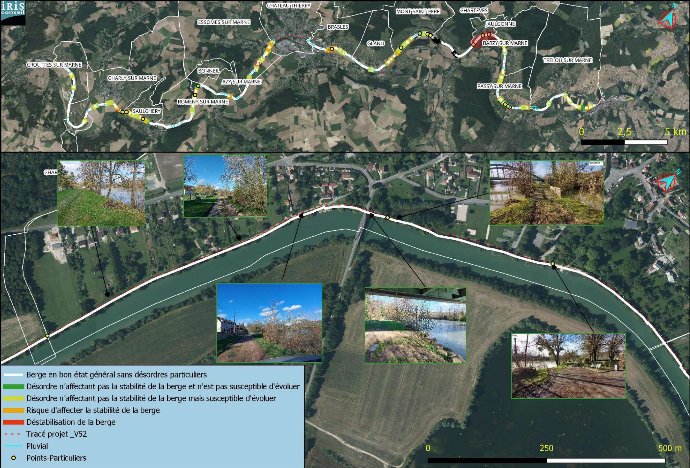
Diagnostic de berges - Zoom sur la commune de :JAULGONNE ( Pas de désordres particuliers sur la berge)
