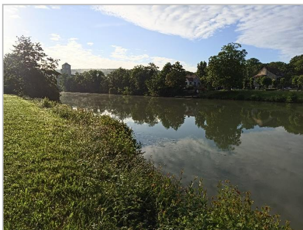
Photo 65 : Berge sans végétation aquatique ni ripisylve © Rainette 2024
