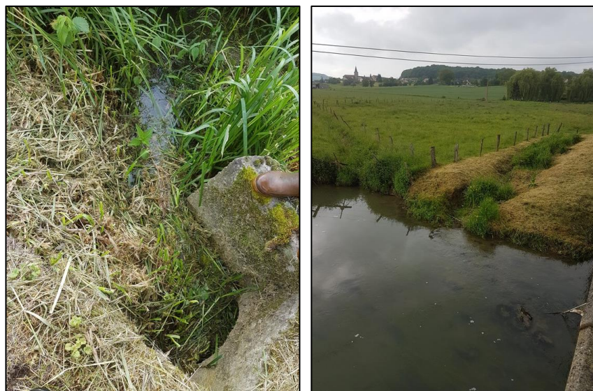
Photographies de l'exutoire du tronçon n°2
