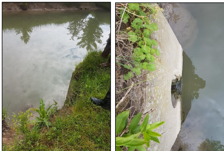
Photographies de l'exutoire du tronçon n°4
