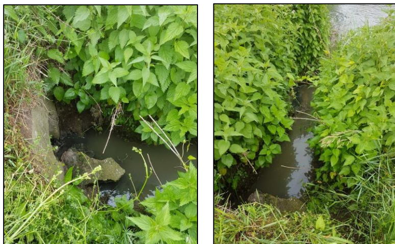
Photographies de l'exutoire du tronçon n°1
