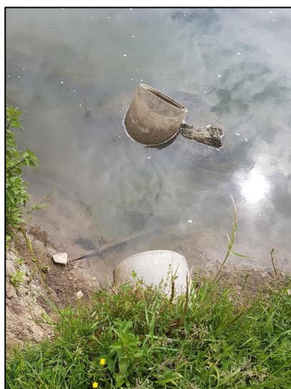
Photographie de l'exutoire du tronçon n°3
