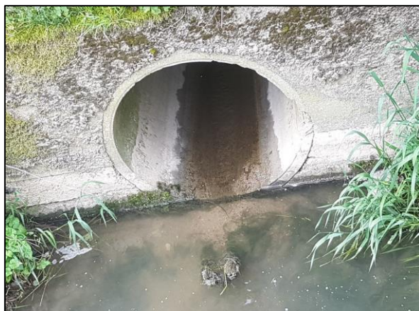
Photographie de l'exutoire du tronçon n°6
