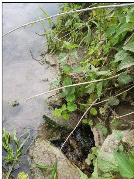
Photographie de l'exutoire du tronçon n°9
