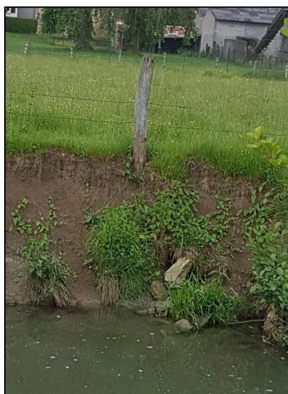
Photographie de l'exutoire du tronçon n°5
