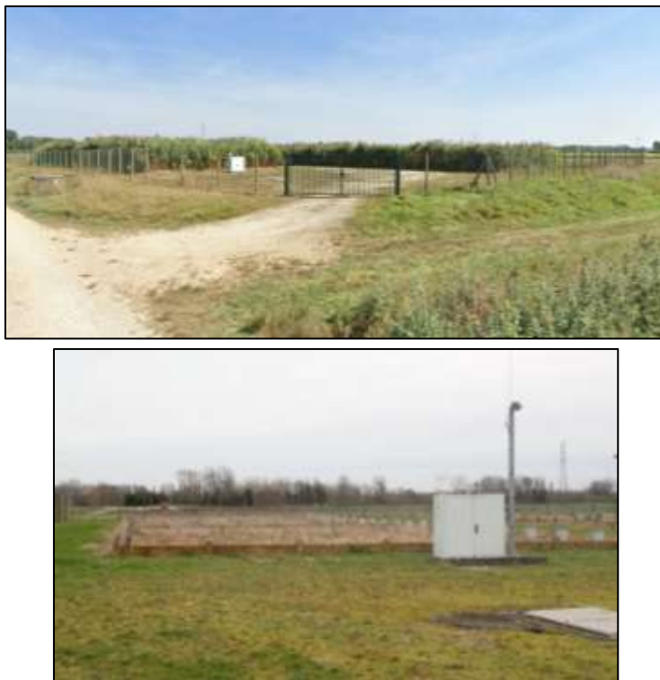
Photographie 9. Station d'épuration collectant les eaux de Saint-Thibault (Mosaïque Environnement, 2024)
