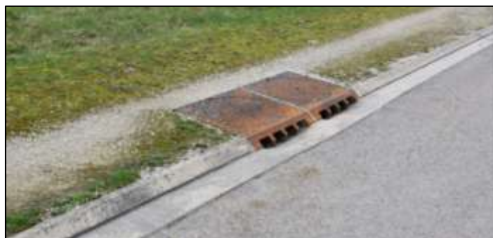
Photographie 11. Avaloirs récupérant les eaux de pluie sur la commune (Mosaïque Environnement, 2024)
