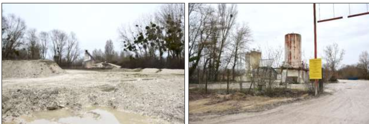
Photographie 3. SAS Conception Réalisation Béton Prêt à l'Emploi (Mosaïque Environnement, 2024)
