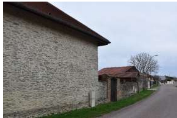
RD93 – Route de Vaudes – Entrée Nord hameau
