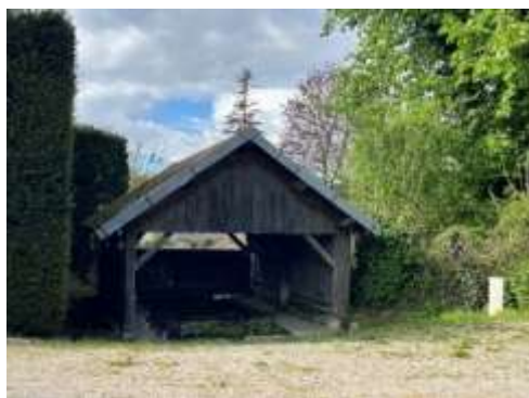
Lavoir – Rue des Champignons
