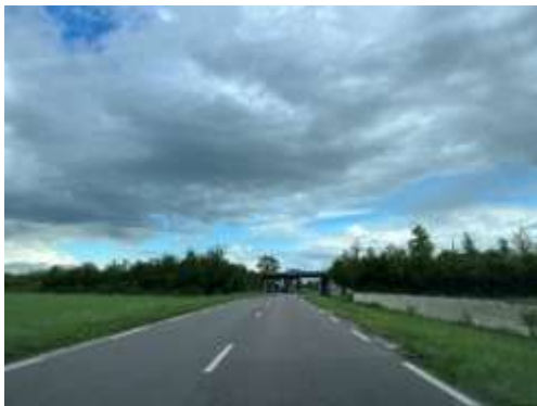
Vue sur le pont de l'A5 depuis la RD 671
