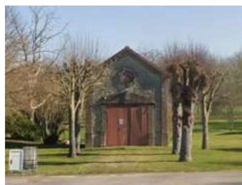
Ancien local pompiers
