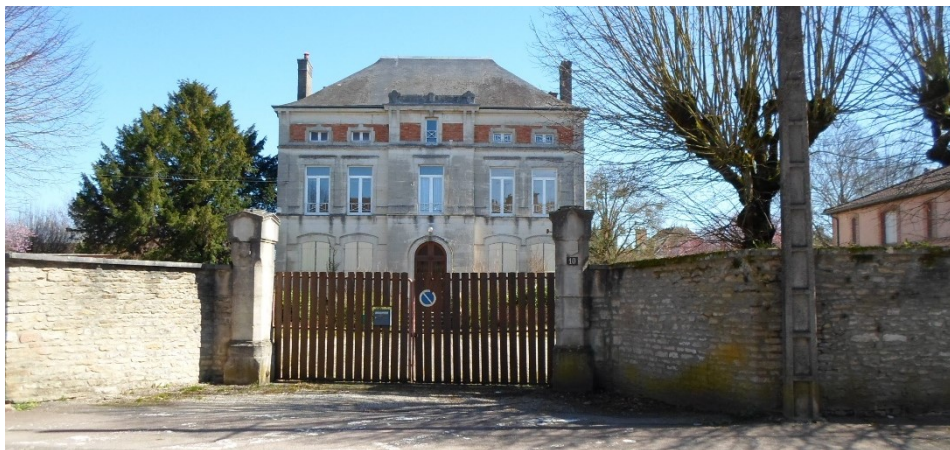
(2) Exemple d'implantation d'un bâtiment en retrait de la limite du domaine public – 10, rue du Général de Gaulle. Un mur et un portail assurent l'alignement avec la rue
