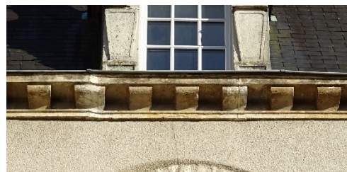
Corniche en pierre de taille à modillons – 33, rue d'Aube
