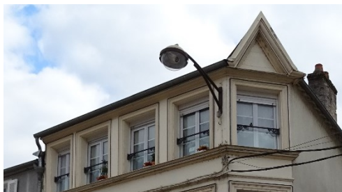
Corniche en bois mouluré – 21, rue Nationale
