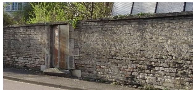
(3) Exemple de mur en maçonnerie de moellons de pierre calcaire et un rejointoiment « à fleur » - Le couvrement est en pierre de taille - Bd de la République.
