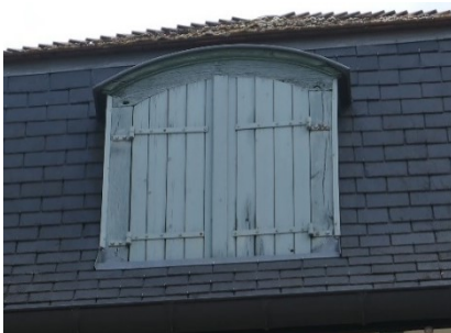
Lucarne en bois avec un linteau cintré - 72, rue Nationale
