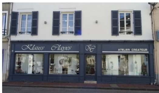
(5) Devanture en applique, en bois, avec panneaux moulurés et bandeau supérieur, support de l'enseigne 5, rue du Théâtre
