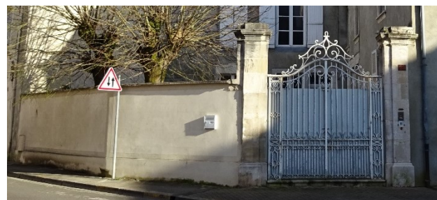
(5) Exemple de mur en maçonnerie recouvert d'un enduit à la chaux taloché - Le couvrement est pierre de taille – 29, rue d'Aube
