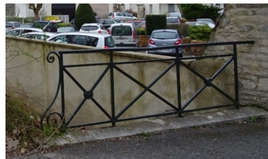
(11) Exemple de garde-corps en serrurerie en croix de St André -5, boulevard Gambetta
