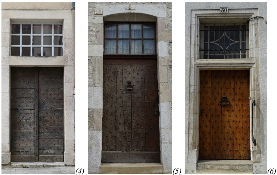
Portes en bois à double parements avec clous et impostes vitrées – (4) 4, rue Delaunay (5) 13, rue d'Aube - (6) 30, rue d'Aube
