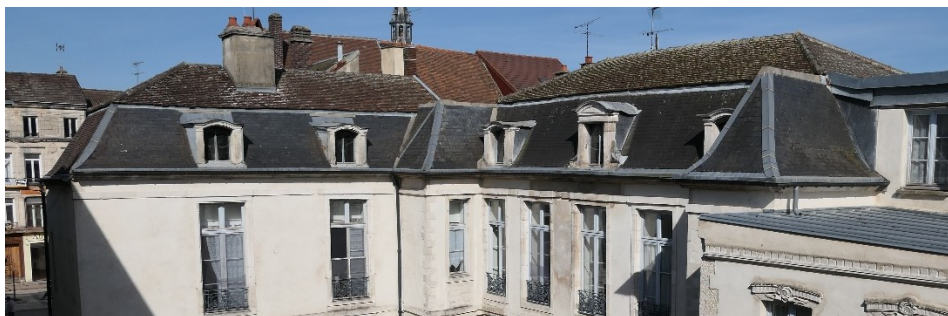
Exemple de toiture à pan brisé avec la partie supérieure « à croupe » couverte en petites tuiles plates et partie inférieure à la « Mansart » couverte en ardoise - Hôtel particulier 3, rue Nicolas Bourbon
