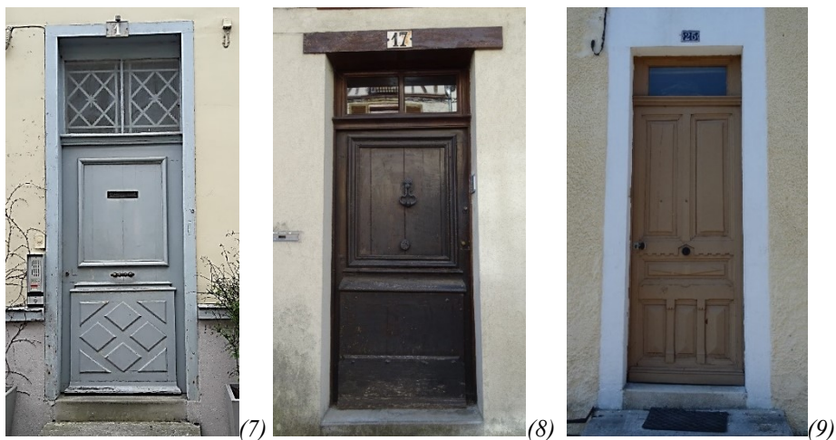
Portes à un battant en bois à panneaux d'assemblage et à imposte vitrée (7) 1, rue Masson de Mortefontaine (8) 17, rue St Maclou (9) 25, rue Gaston Bachelard
