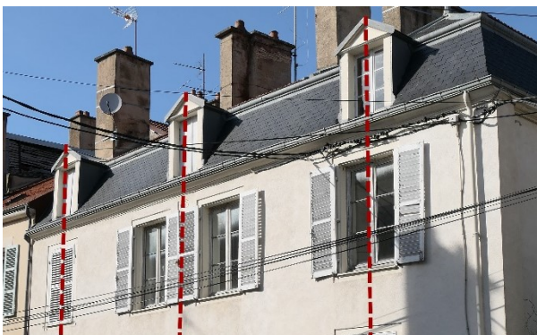
(3) Lucarnes charpentées à deux pans, axées sur les fenêtres ou les meneaux 4, rue Masson de Mortefontaine
