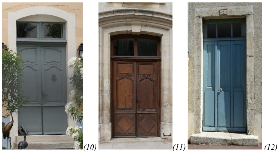
Portes, en bois à panneaux d'assemblage et à imposte vitrée à deux battants : (10) 4, place St Maclou (11) 11, rue du Collège - (12) Porte tierce 18, boulevard du 14 juillet
