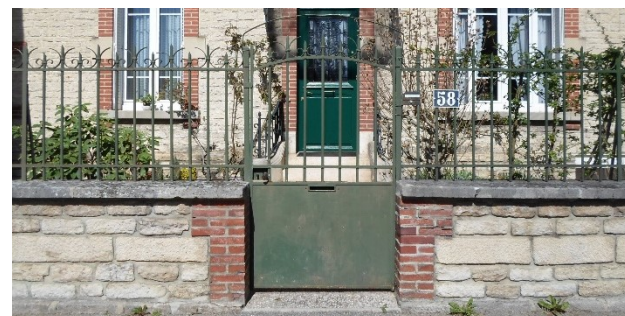
(6) Exemple de clôture composée d'un mur bahut en maçonnerie de pierre de taille, surmonté d'une grille en ferronnerie - 58, Bd Gambetta
