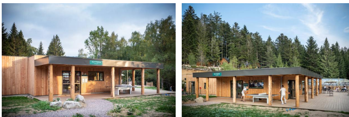
Figure 6 : Photos du nouveau centre de vie Source : Huttopia
