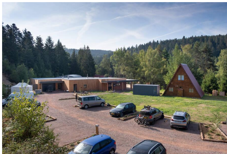
Figure 13 : Parking réalisé dans le cadre des travaux Source : Huttopia
