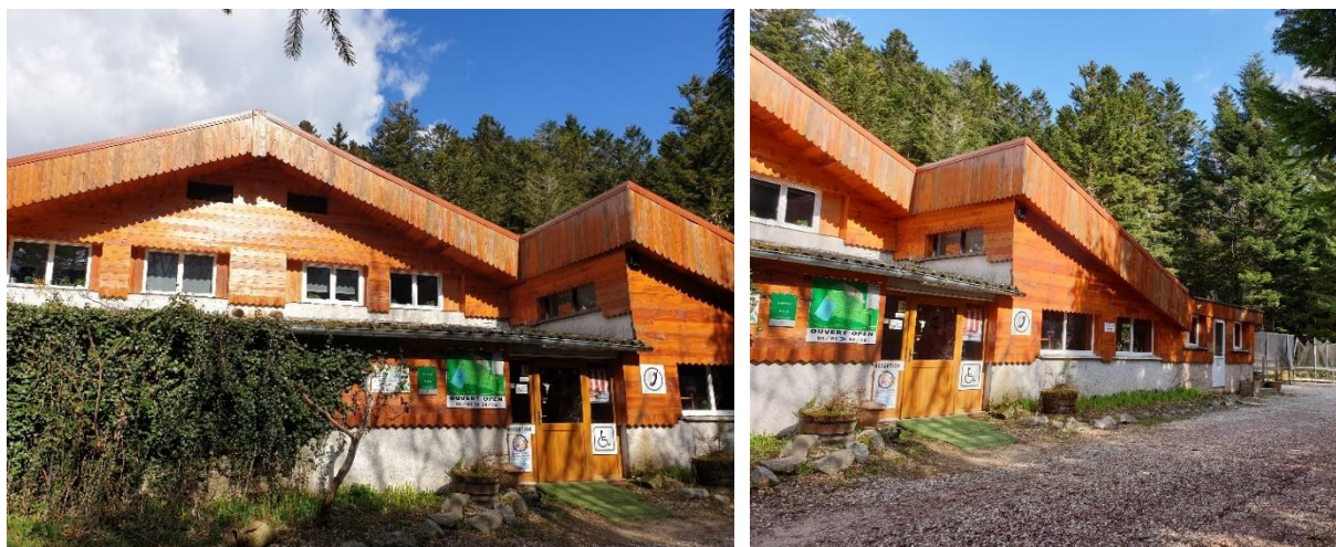
Figure 5 : Photographies du bâtiment d'accueil existant Source : MDP Consulting
