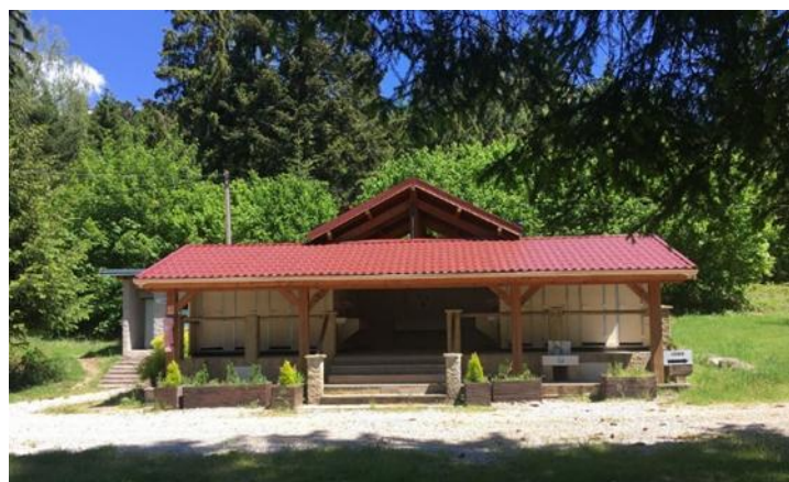
Figure 9 : Bâtiment sanitaire existant Source : Huttopia
