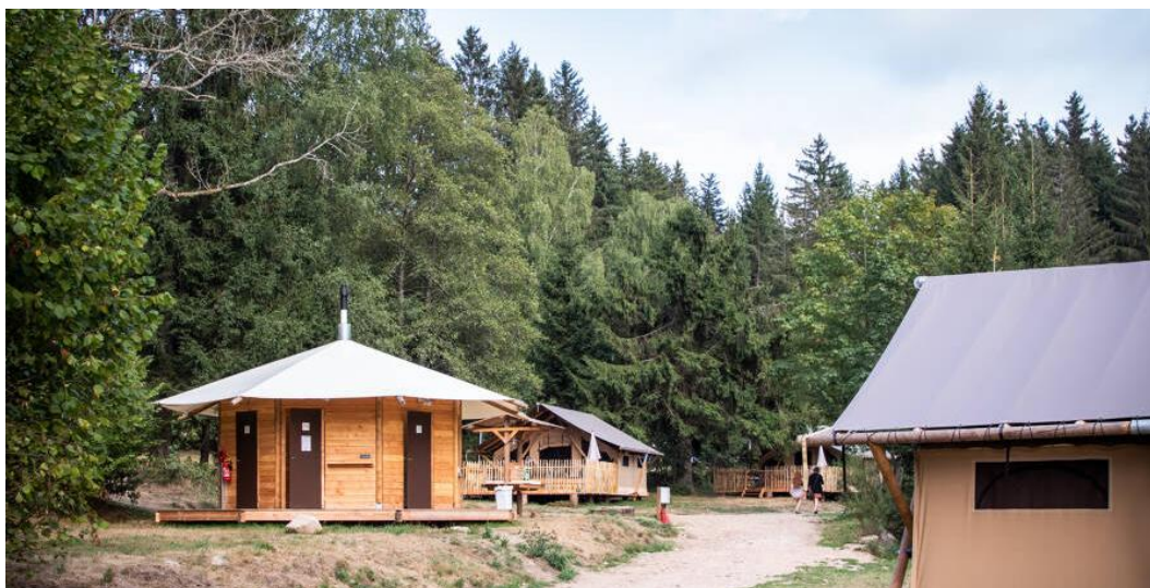
Figure 10 : Photo du sanitaire modulaire installé Source : Huttopia
