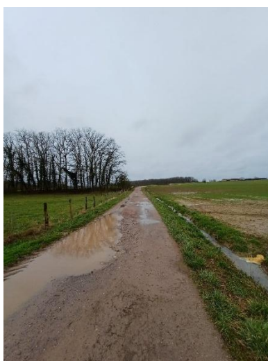
Photographie 21 : Chemin empierré à recharger avec mise en place de bois d'eau pour favoriser l'écoulement à gauche et chemin enherbé à empierré à droite
