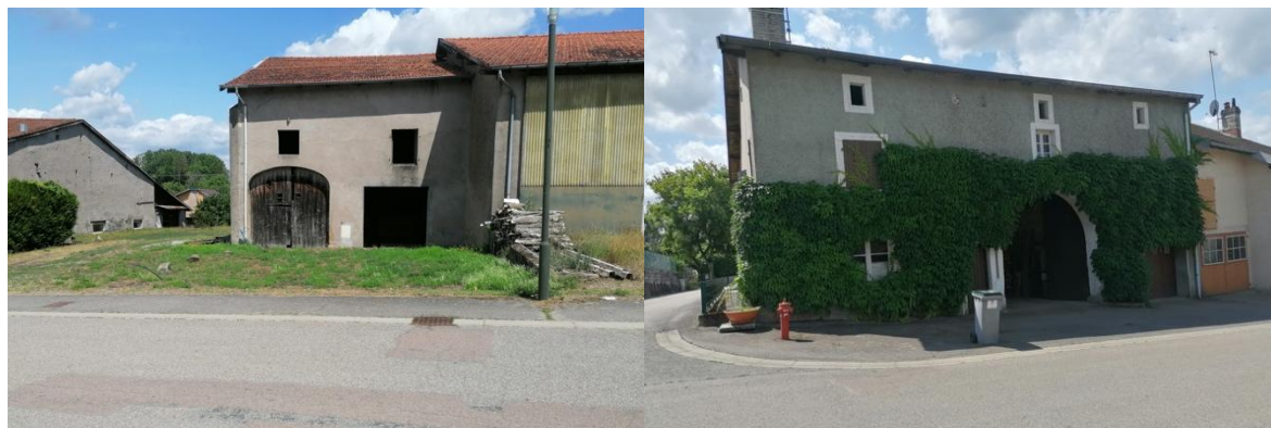
Photographie 16 : Constructions anciennes rencontrées à Girmont
