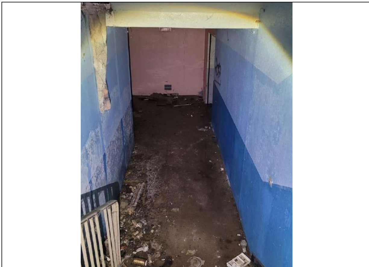
Accès actuel à la cave par l'escalier situé à l'intérieur du bâtiment
