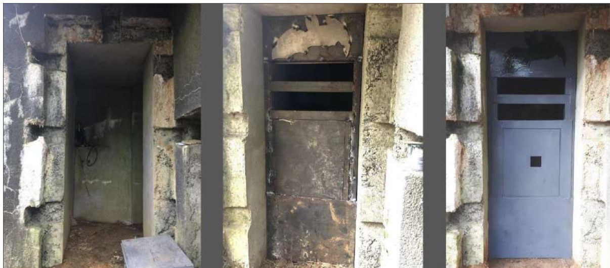
Figure 22 : Illustration de sécurisation d'un accès à l'aide d'une porte métallique et d'un accès chauves-souris (Source : CPEPESC-Lorraine)
