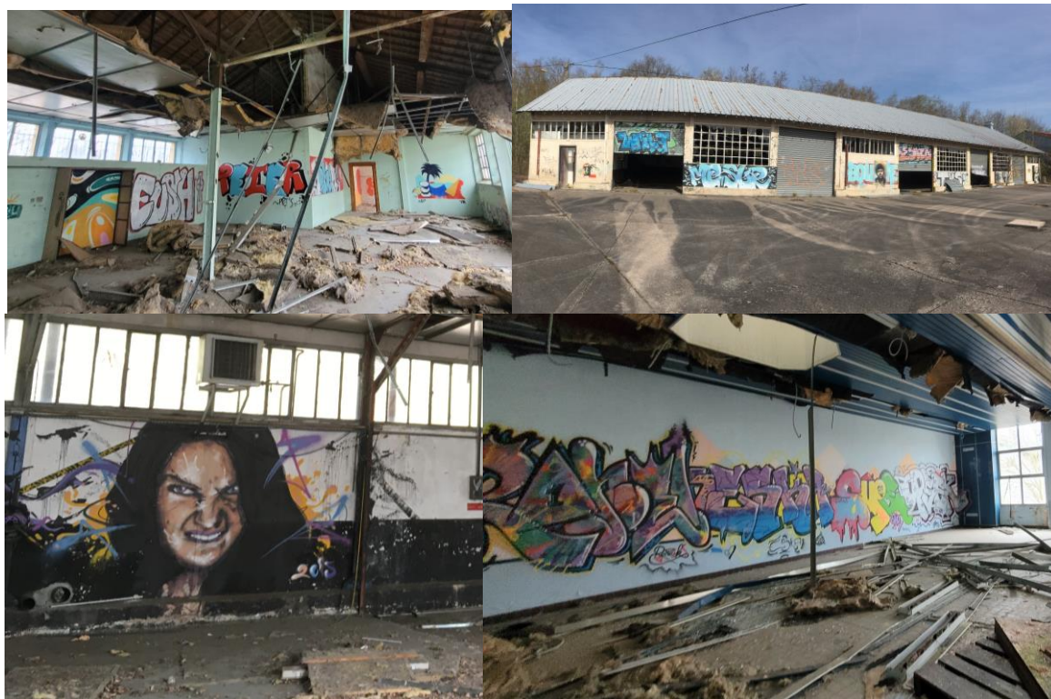
Figure 94 : Photos du site à l'intérieur des bâtiments
