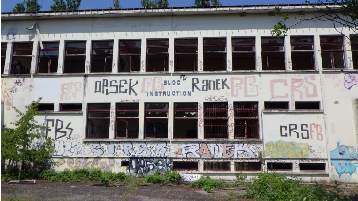
Figure 100 : Bâtiment 32 préservé en partie pour des espèces
