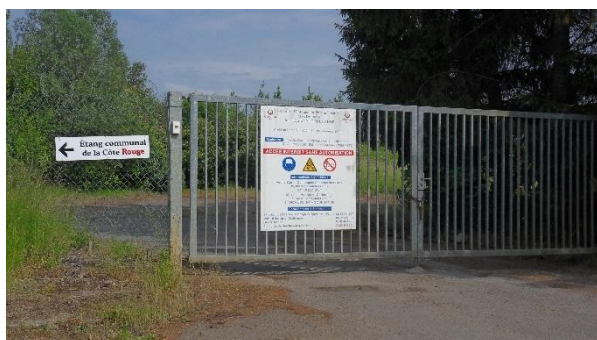
Centre d'Enfouissement Technique des déchets.
