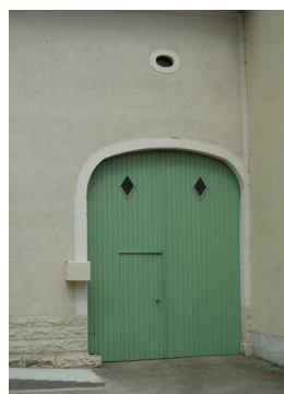
40. ARRONDI DE PORTE DE GRANGE AVEC PIERRES APPARENTES DES OUVERTURES ; CEIL DE BŒUF
