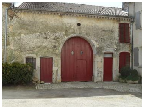
39. ARRONDI DE PORTE DE GRANGE, DE PORTE DE SERVICE ET FENÊTRE AVEC PIERRES APPARENTES DES OUVERTURES ; CEIL DE BŒUF
