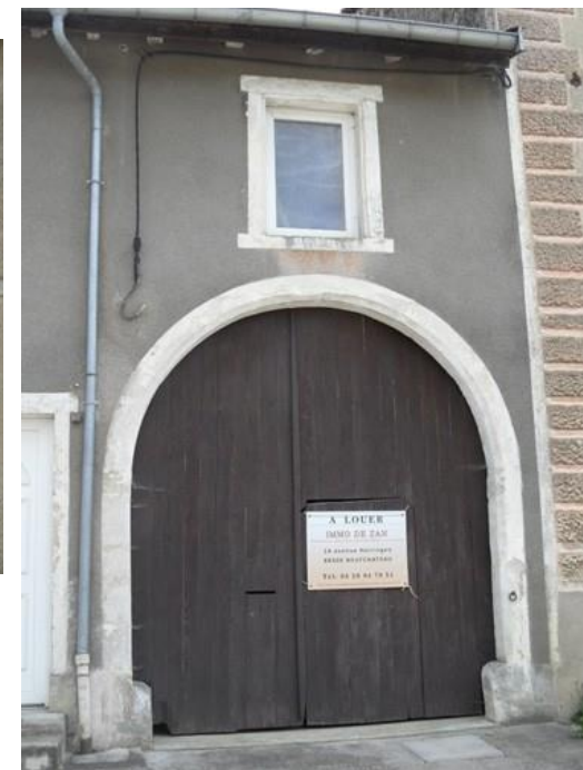
36. PIERRES APPARENTES DES OUVERTURES ; LINTEAU PORTE D'ENTRÉE ; ÉVACUATION D'EAU ÉVIER
