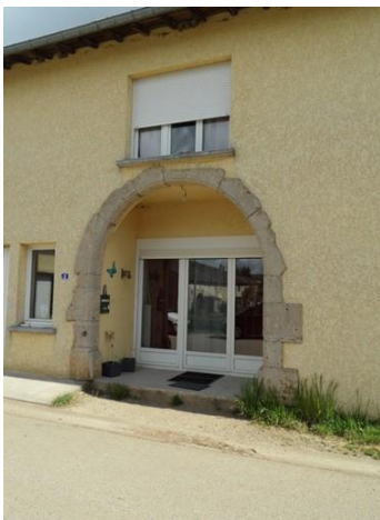
33. ARRONDI DE PORTE DE GRANGE AVEC PIERRES APPARENTES DES OUVERTURES
