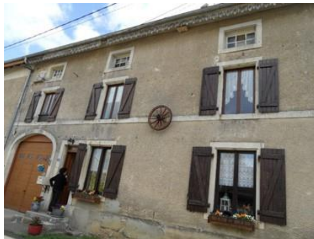
35. ARRONDI PORTE D'ENTRÉE AVEC PIERRES APPARENTES DES OUVERTURES
