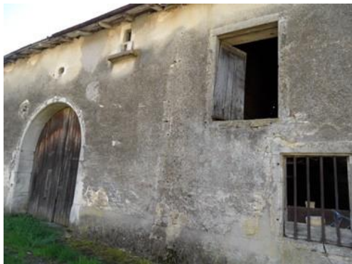
22. ARRONDIS DE PORTE DE GRANGE ET FENÊTRES AVEC PIERRES APPARENTES DES OUVERTURES ; BEUQUETTE ; PLAQUE GRAVÉE
