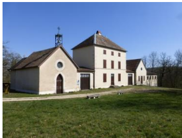
1. CHAPELLE DE BERMONT
