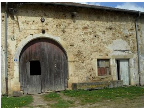
14. ARRONDIS DE PORTE GRANGE AVEC PIERRES APPARENTES DES OUVERTURES
