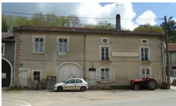
37. ARRONDI DE PORTE DE GRANGE AVEC PIERRES APPARENTES DES OUVERTURES ; PORTE D'ENTRÉE
