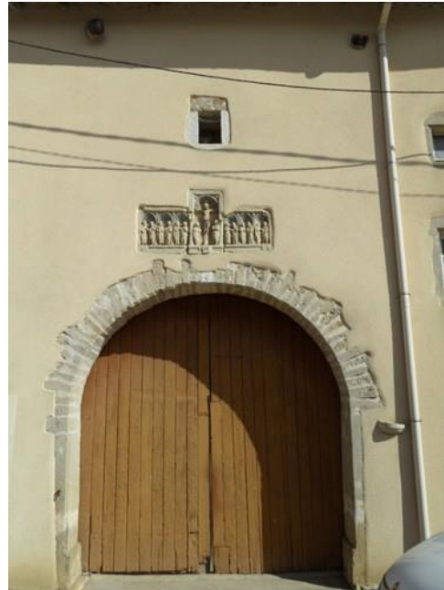
2. ARRONDI DE PORTE DE GRANGE AVEC PIERRES APPARENTES DES OUVERTURES ; RETABLE
