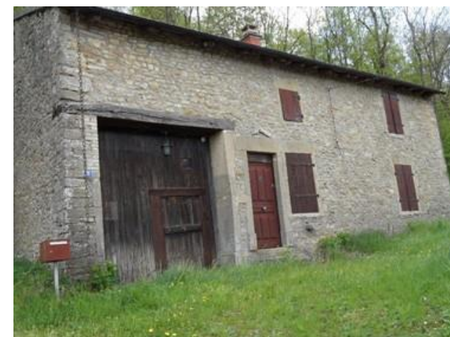
36. PIERRES APPARENTES DES OUVERTURES ; LINTEAU PORTE D'ENTRÉE ; ÉVACUATION D'EAU ÉVIER
