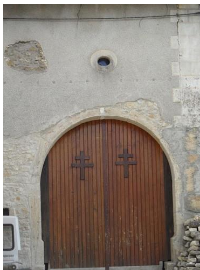
34. ARRONDI DE PORTE DE GRANGE AVEC PIERRES APPARENTES DES OUVERTURES ; ŒIL DE BŒUF
