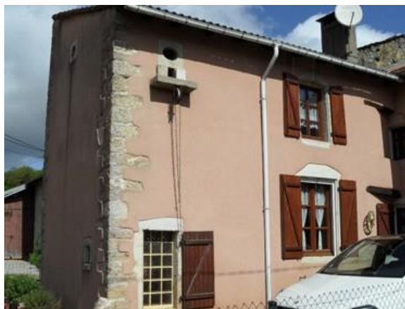
24. ARRONDI DE FENÊTRE AVEC PIERRES APPARENTES DES OUVERTURES
