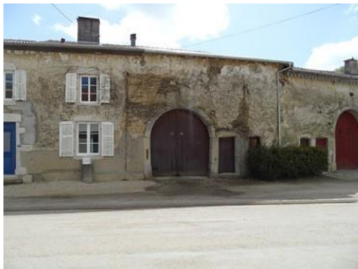
38. ARRONDI DE PORTE DE GRANGE ET PORTE DE SERVICE AVEC PIERRES APPARENTES DES OUVERTURES
