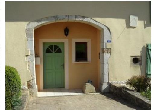
4. ARRONDI PORTE DE GRANGE AVEC PIERRES APPARENTES DES OUVERTURES ; BEUQUETTE (ŒIL DE BŒUF AU-DESSUS DE L'ÉVIER)
