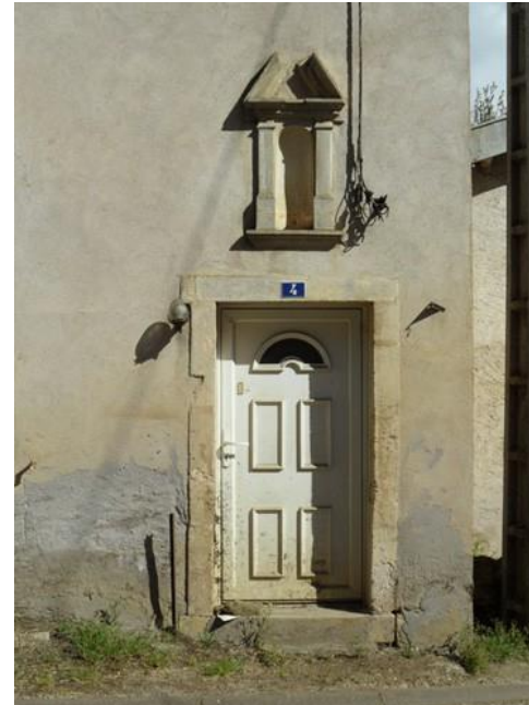
3. NICHE ARCHITECTURALE AU-DESSUS DE LA PORTE D'ENTRÉE ET PIERRES APPARENTES DES OUVERTURES
