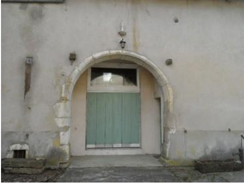
10. ARRONDI DE PORTE DE GRANGE AVEC PIERRES APPARENTES ; NICHE AR- CHITECTURALE ; ARRONDIS DE PORTE ET FENÊTRE AVEC PIERRES APPARENTES DES OUVERTURES
