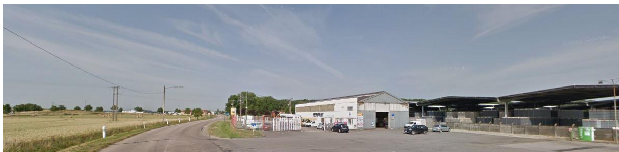
VU SUR L'ENSEMBLE DU SITE
