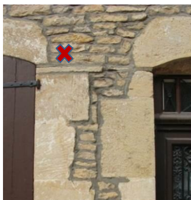
Joints au ciment gris interdits
