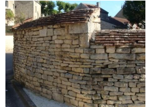
Murs d'assises régulières de pierre calcaire sans joint apparent et couronnement en petites tuiles plates ou en tuiles mécaniques
