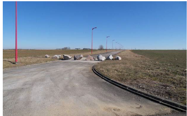
Une voirie fermée en attente de la construction de bâtiments
