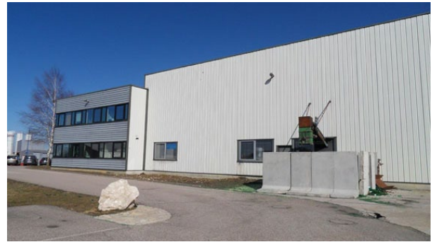
Arrière de bâtiment non traité
