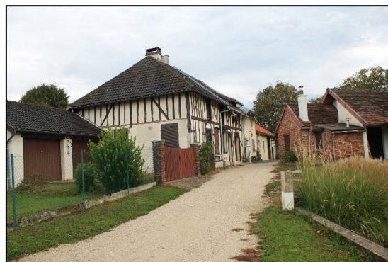
Ferme à cour, rue Raymond Poincaré.
