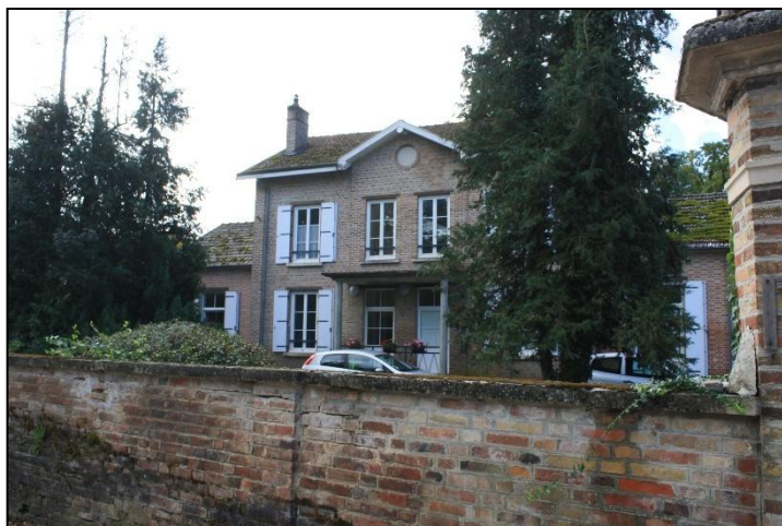
Maison urbaine le long de la RD619
