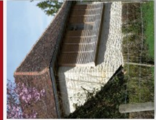
Pierre et tuile plate, association de moellons calcaire et de bardage bois, La Villeneuve-au-Chêne
