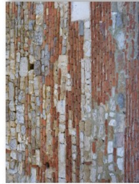
Maçonnerie mixte brique, pierre calcaire, craie, Montierarmey
