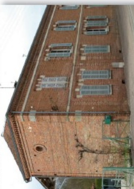
Volets bleus dans une façade de pierre avec chaînages brique, linteaux et fenêtres bois. Montreuil-sur-Barse
