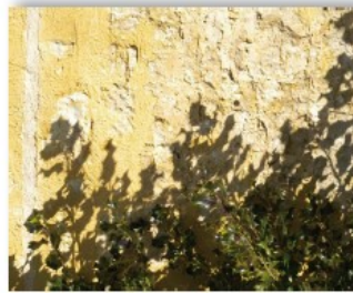
Maçonnerie de calcaire avec enduit à pierre vue, chaux + sable ocre, Chauffour-lès-Bailly
