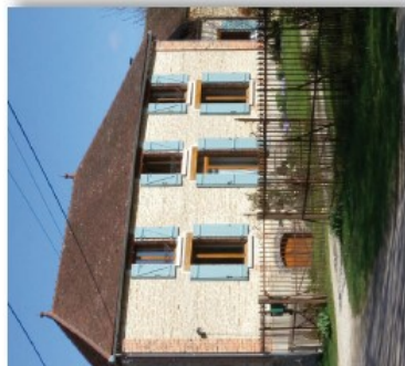
Volets bleus dans une façade de pierre avec chaînages brique, linteaux et fenêtres bois. Montreuil-sur-Barse
