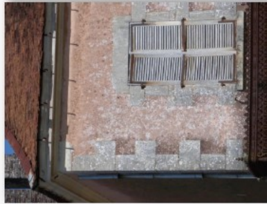
Pierre de taille et maçonnerie enduite, Molins-sur-Aube
