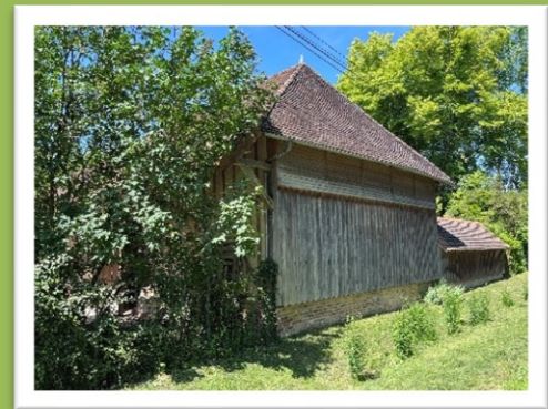
Façade de la grange visible depuis l'espace public
