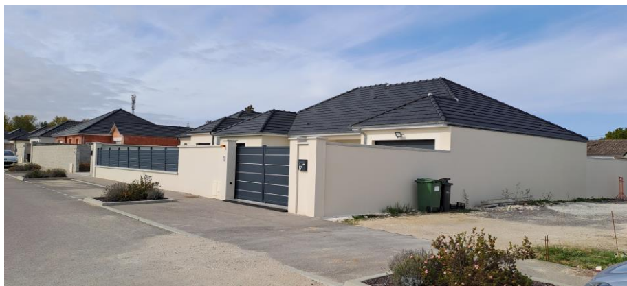
Photo 9. Type de bâti récent
