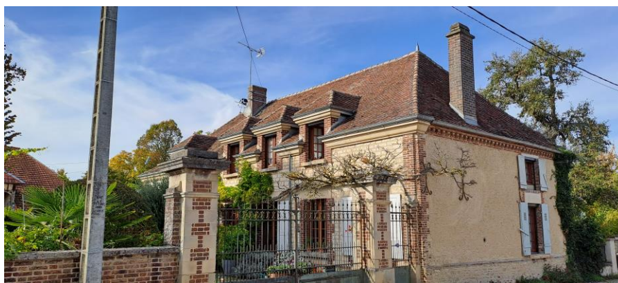
Photo 7. Bâti du 19 ème siècle
