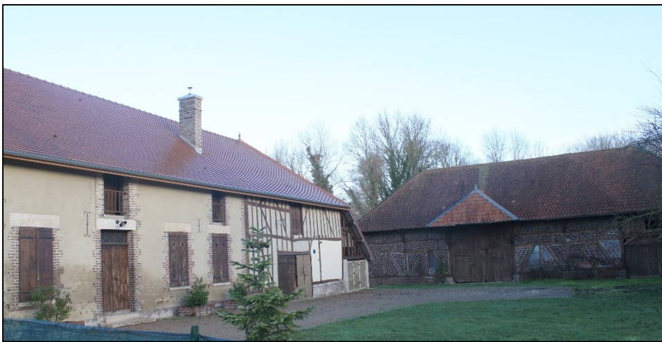
Ferme et hangar en pans de bois à proximité du centre, le long de la RD109.
