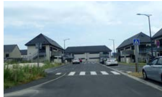
La rue du Général de Gaulle est une voie tertiaire disposant d'un trottoir et d'un éclairage public.
