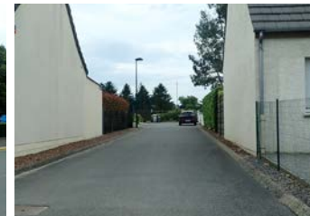
L'accès potentiel depuis la voie tertiaire au nord de la zone. La voie est pourvue d'éclairage public mais pas de véritables trottoirs. Toutefois, une accroche viaire est prévue en bout de voirie.
