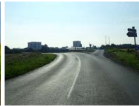
La RD960 est une voie primaire fréquentée non pourvue de trottoir et d'éclairage public.
