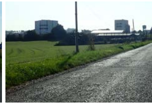
Aucun accès n'est aménagé depuis la rue Paulin Pecqueux, mais les accès sont possibles en façade de zone.
