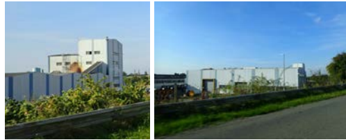
Exemples de bâtis économiques implantés de l'autre côté de la voie ferrée. Les bâtis sont en tôles. Les coloris sont clairs et les hauteurs moyennes à hautes (environ 8m à plus de 15m).
