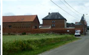
La ferme voisine est en brique et en béton. Sa hauteur est en R+C et R+1+C.
