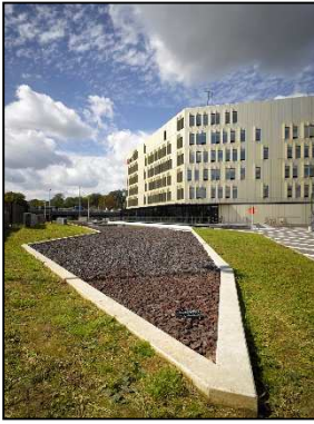
Massif d'infiltration à forte porosité
