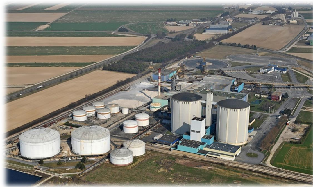
Site de la sucrerie Tereos de Connantre
