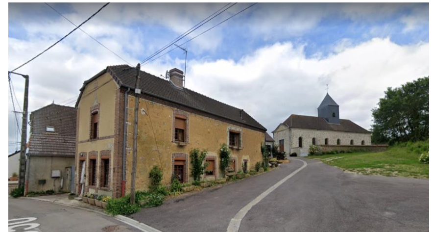
18 rue de l'Abbaye Maison individuelle RDC+ 1
