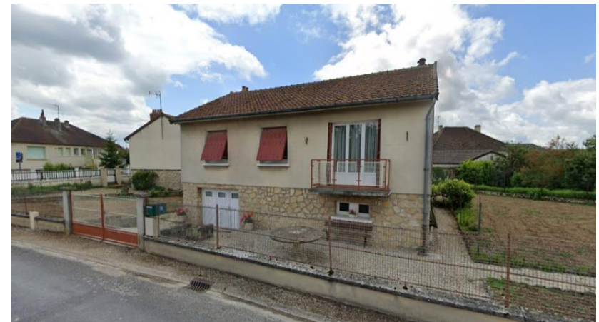
12 rue Léon Gambetta Maison individuelle RDC+ combles
