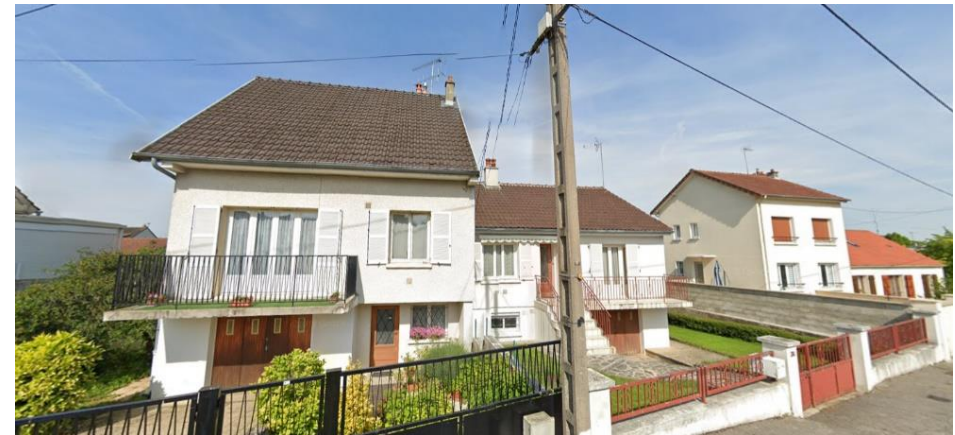
23 rue des Roses Maisons individuelles RDC+1 / RDC+ combles
