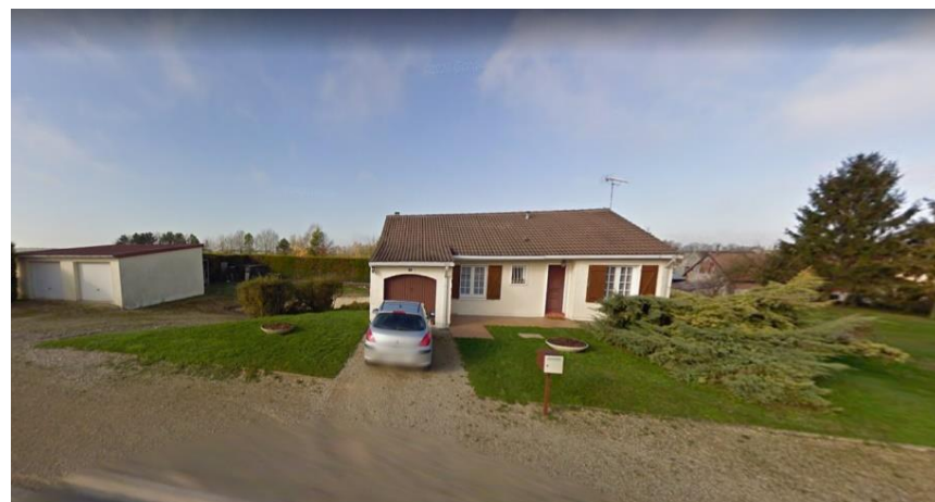
2 rue de la Plaine Maison individuelle RDC+ combles
