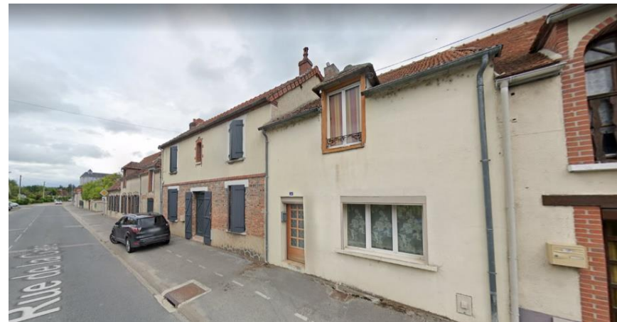
34 rue de la Gare Maisons de ville mitoyennes RDC + 1
