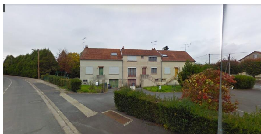
Rue du Général Leclerc Maisons mitoyennes RDC+1
