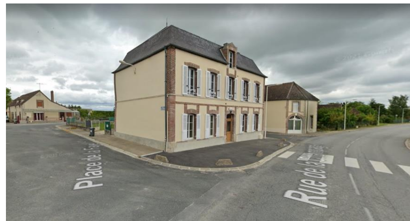
37 rue de la Champagne Maison de ville RDC+1
