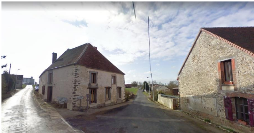
Rue de l'Église Maisons individuelle, RDC+1
