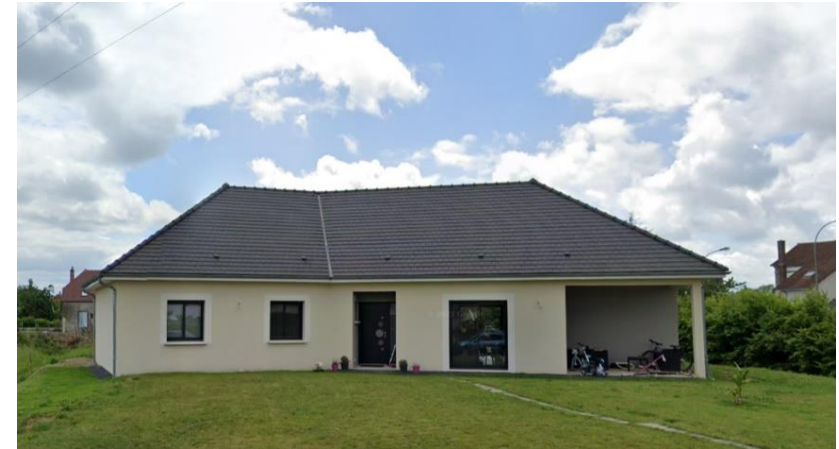
4 rue Louis Pasteur Maison individuelle RDC+ combles
