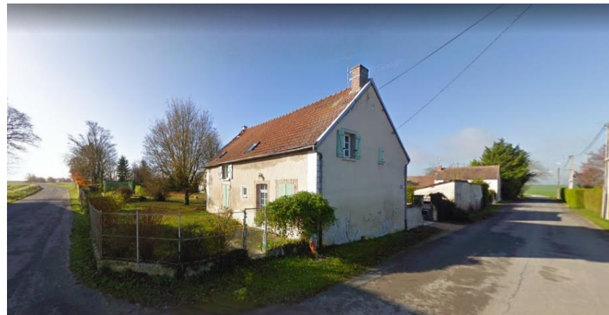
31 rue de l'Église Maison individuelle RDC+1
