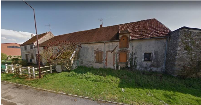
9 rue des Templiers Maison individuelle RDC+1
