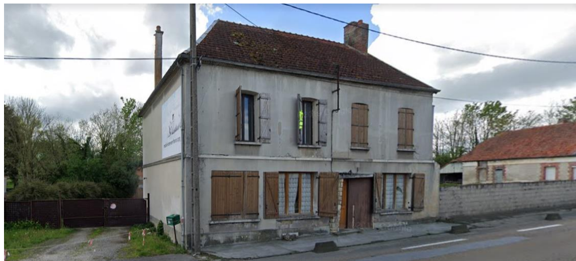
10 Route Nationale Maison individuelle RDC+1
