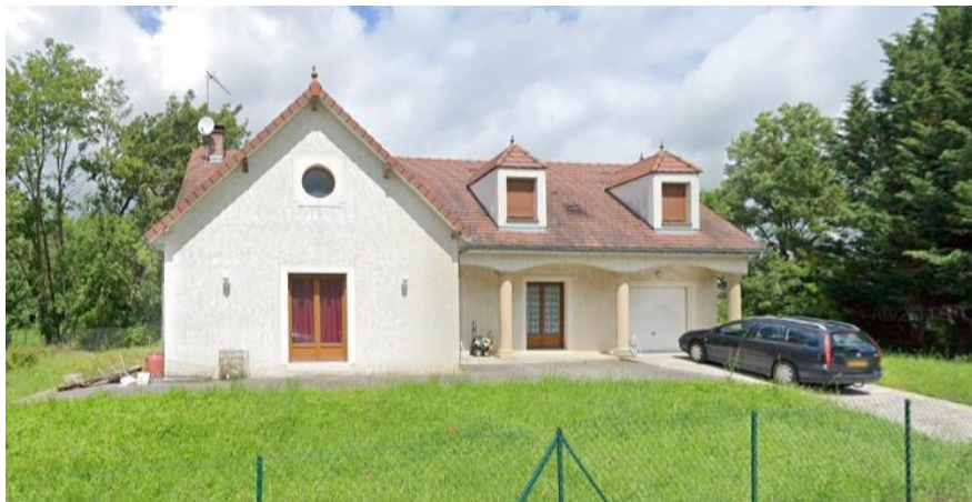
82 rue Marcel Cachin Maison individuelle RDC+ combles
