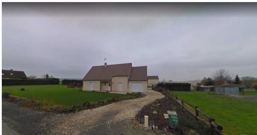
8 rue de Champigny Maison individuelle pavillonnaire RDC+ combles
