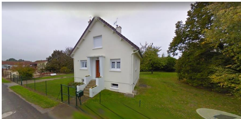
Rue Jacquillon Maison individuelle RDC+1
