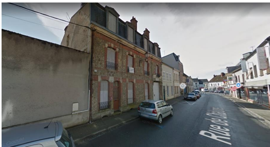
18 rue des Châlons Maisons de ville mitoyennes RDC+2
