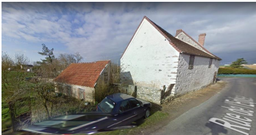
40 rue de l'Église Maison individuelle RDC+ combles
