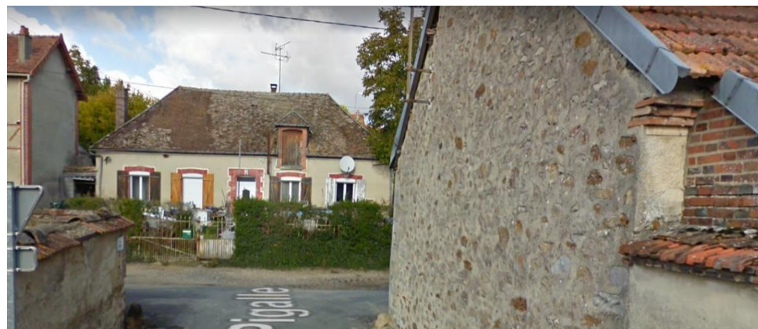
Rue de Ctre Maison individuelle RDC+ combles
