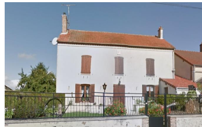
Rue du Chateau Maison individuelle RDC+ 1
