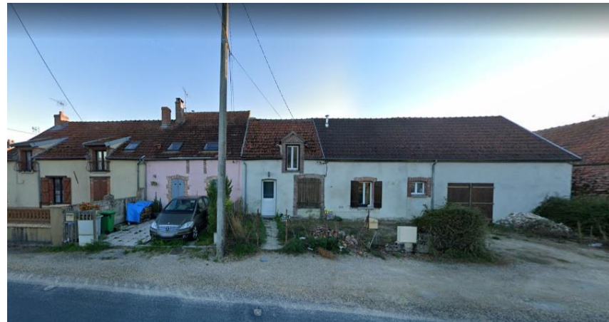
Rue Pierre Brocheton Maisons mitoyennes RDC+ combles
