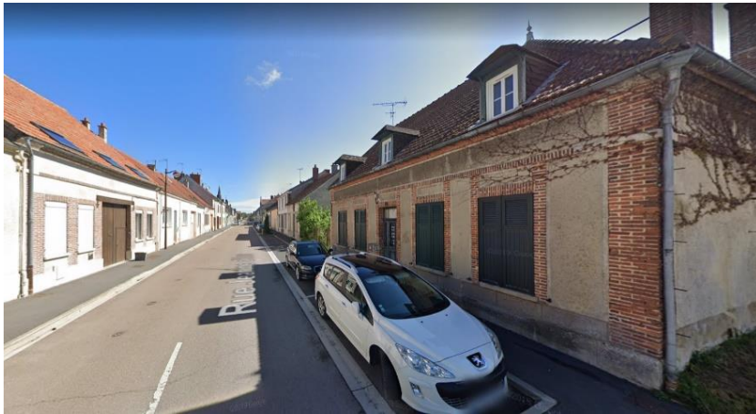
168 Rue Jeanne d'Arc Maisons de ville mitoyennes RDC+ combles
