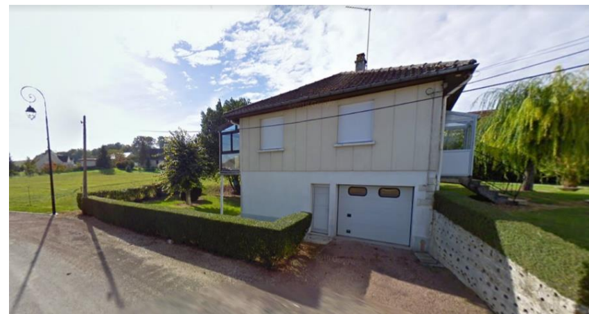
Rue des Accins Maison individuelle RDC+1
