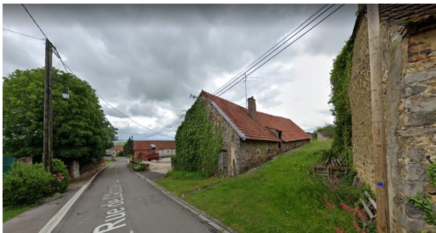
9 rue de l'Abbaye Maison individuelle RDC+1
