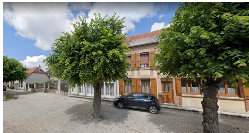
4 avenue des Tilleuls Maisons de ville mitoyennes RDC+1
