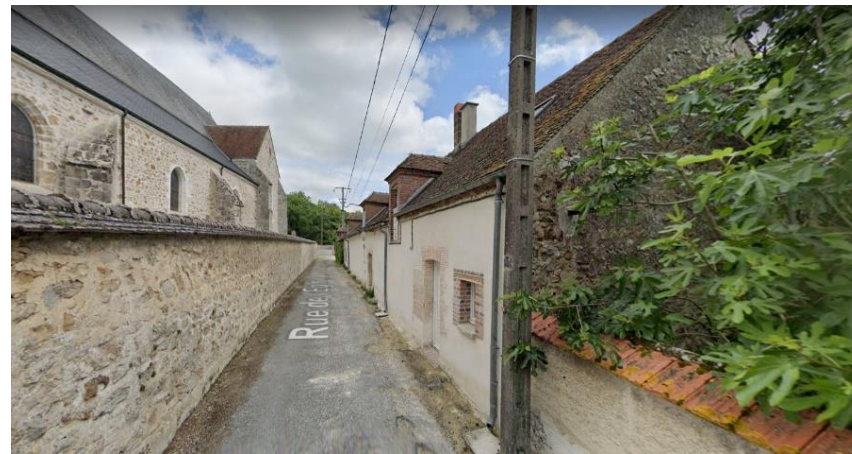
1 rue de l'Eglise Maisons de ville RDC+ combles
