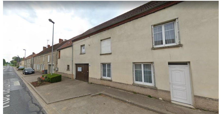
185 rue de l'Empereur Maisons mitoyennes RDC+1
