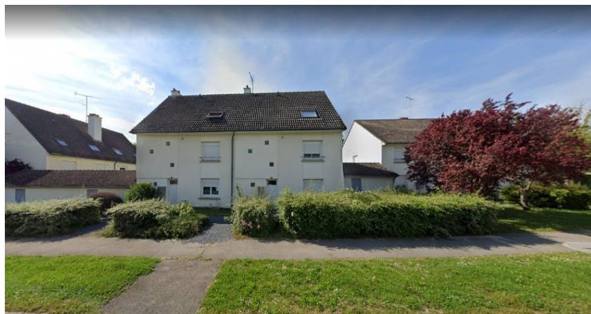
Boulevard de Malsh Maisons individuelles mitoyennes RDC+1
