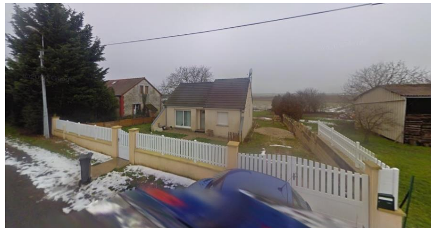
17 rue de la Source aux Loups Maison individuelle, RDC+ combles
