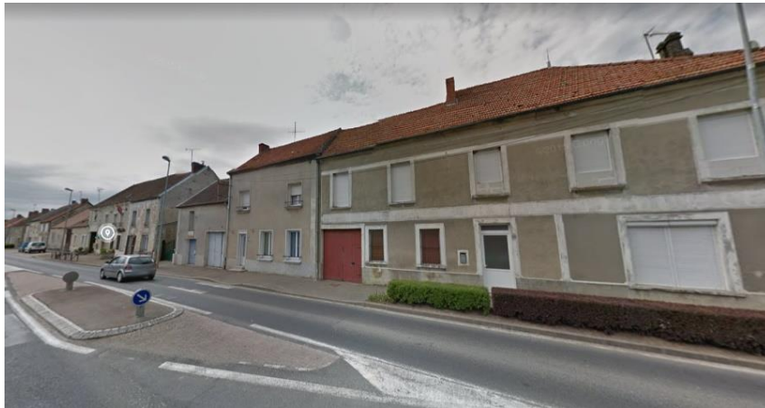
255 rue de l'Empereur Maisons mitoyennes RDC+1
