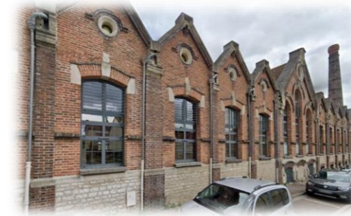
Anciens ateliers et usine de bonneterie Journé-Lefèvre
