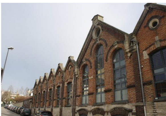
Ancienne Usine de bonneterie Journé-Lefèvre rue Blanche Pierre
