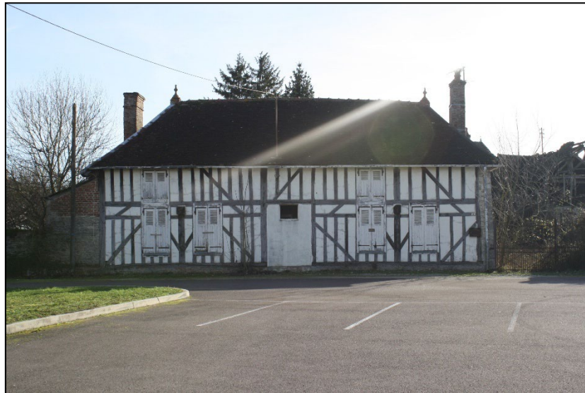
Construction en pan de bois, vue depuis le parking de la mairie
