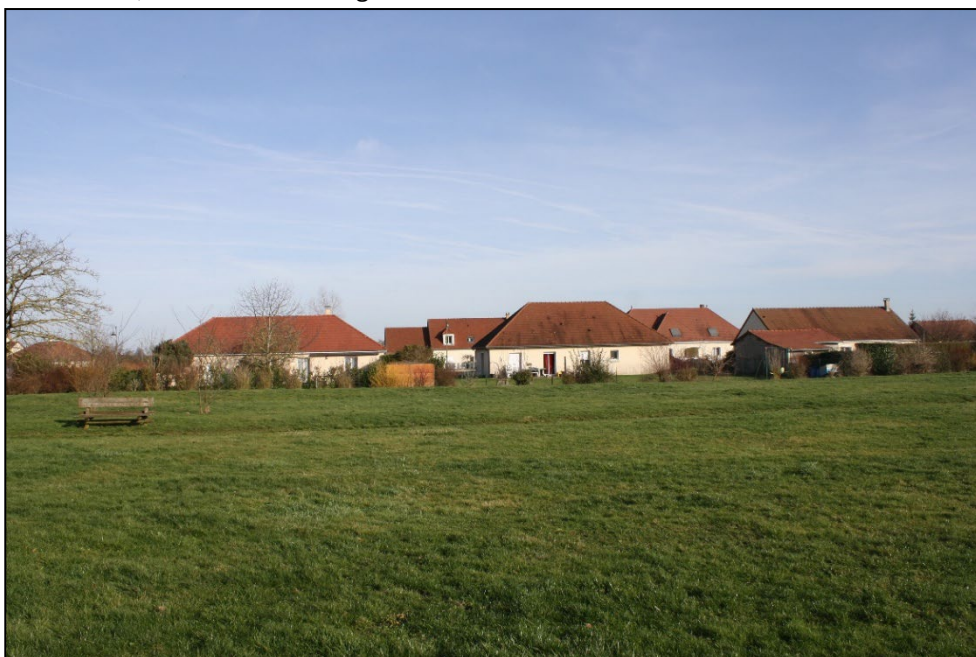
Constructions récentes vues depuis le parc du city stade
