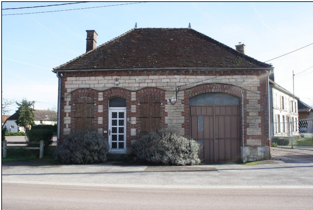
Construction arborant des briques, rue de la Trinité
