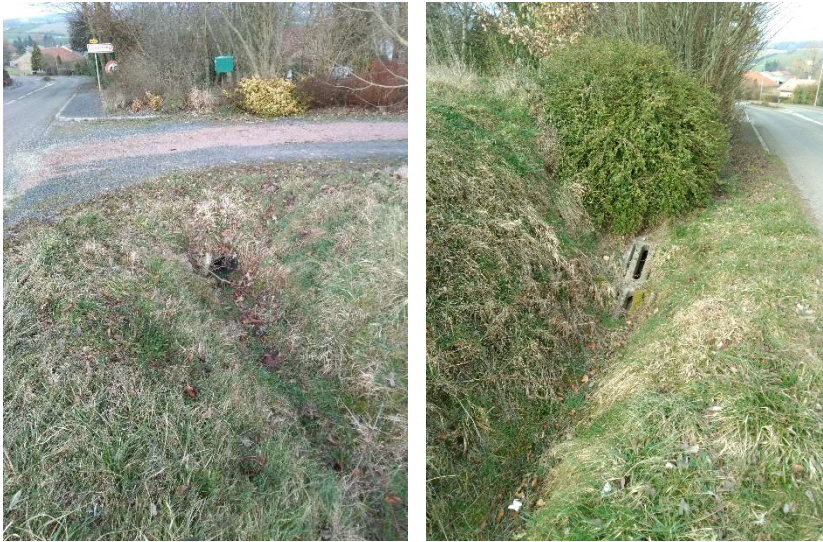
Photo 2: arrivée fossé route de Rambervillers
