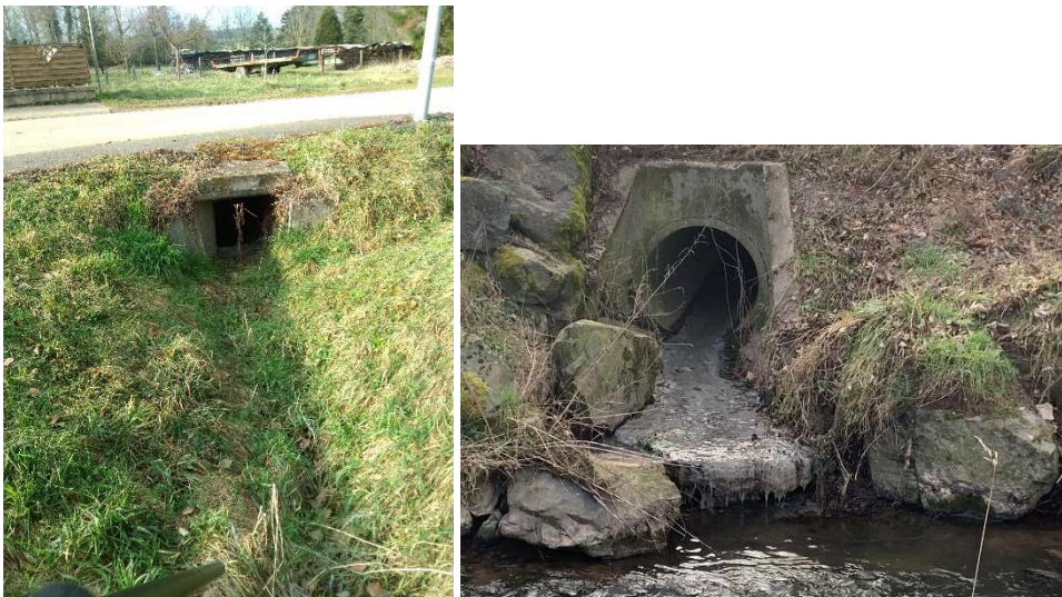
Photo 3: Arrivée fossé chemin des Grandes friches et exutoire
