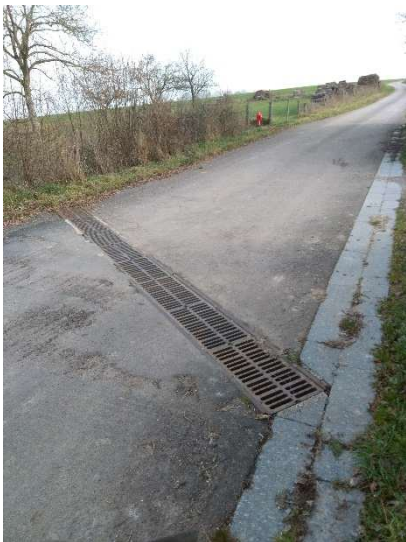
Photo 3: grille rue du Pré Houot
