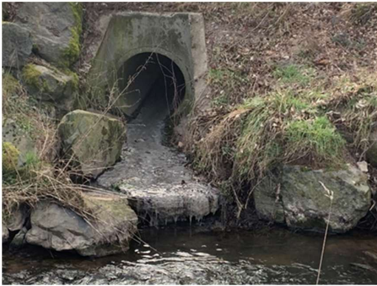
Photo 1: exutoire du réseau de collecte
