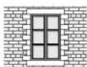
Encadrement de baie en pierre de taille
