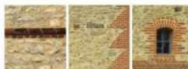
Bandeaux en briques en terre cuite et joints de mortier de chaux Chaîne d'angle en briques en terre cuite et joints de mortier de chaux Encadrement de baie en briques en terre cuite et joints de mortier de chaux
