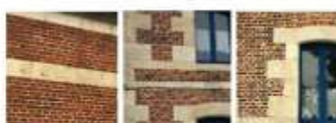
Bandeaux en briques en terre cuite et joints de mortier de chaux
