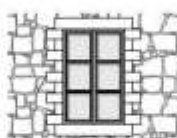
Encadrement de baie en pierre de taille
