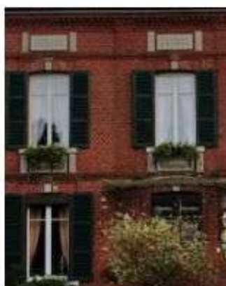
Maison de maître à Éparcy
