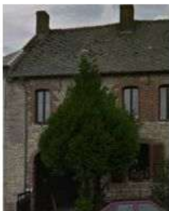
Maison de ville à cour, Louze
