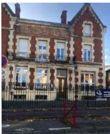
Maison de la reconstruction
