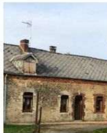
Maison de village, Any-Martin-Rieux
