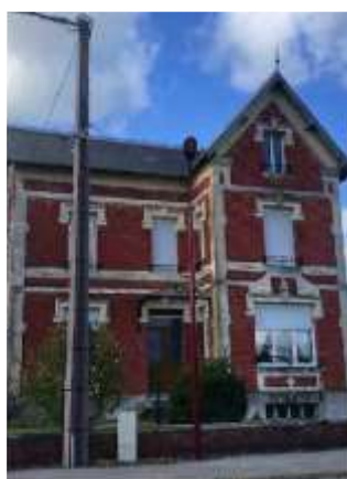
Maison de la reconstruction
