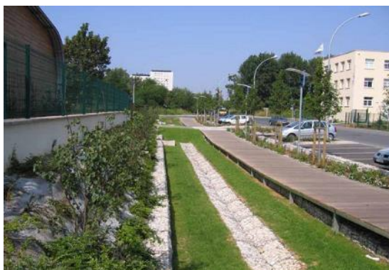
Tranchée drainante dans la ZAC Clichy-Parc à Clichy-sous-Bois
