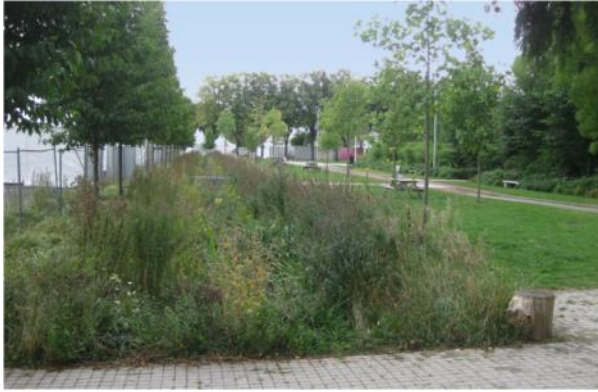
Parc François Mitterrand (Saint-Etienne) : noues et fossés de stockage végétalisés
