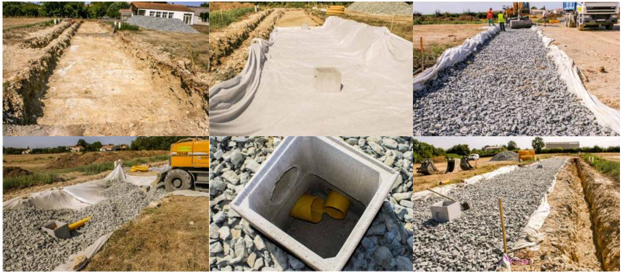
Mise en place d'une chaussée à structure réservoir dans l'écoquartier des Ecluzis à Oulmes (85) (in http://les-ecluzis.fr/actualites/aout-2012-mise-en-place-des-chaussees-reservoirs )
