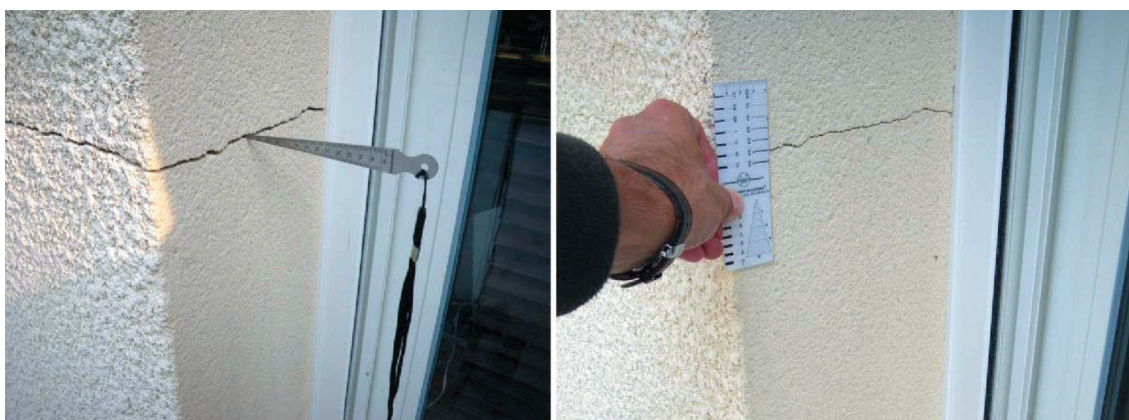
Figure 2 Exemple de la même fissure ouverte de 2 mm en fin d'été et de 0,5 mm en fin d'hiver (Source Socabat)
