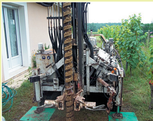
Sondeuse équipée d'une tarière permettant l'échantillonnage des matériaux (Source Cerema)
