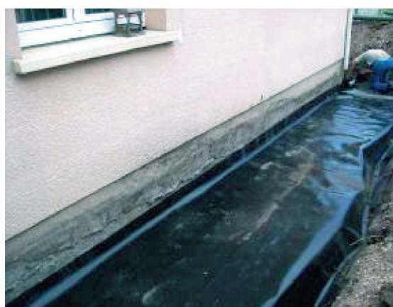
Figure 22 Géomembrane en cours de pose (Source Socabat)
