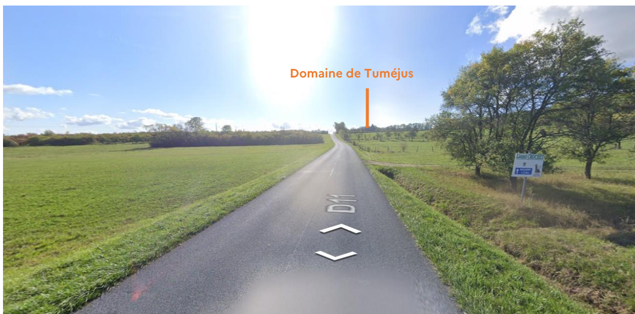
Point de vue n°8 depuis la route départementale n°11 entre Blénod-les-Toul et Bulligny
