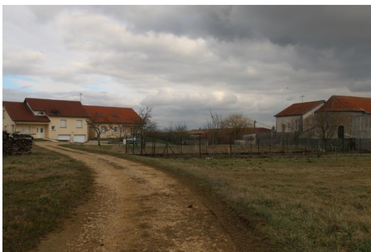
La zone est desservie par un chemin rural qui sera équipé en réseau
