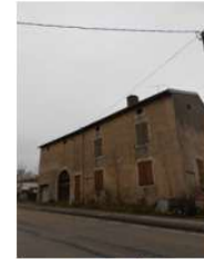
12 rue de Lunéville Vacant
