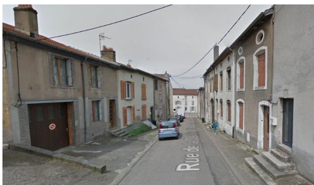
Point de vue n°7– rue de la Cloche
