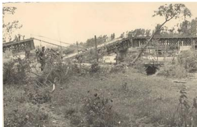
Carte postale ancienne représentant le pont sur la Moselle démolé
