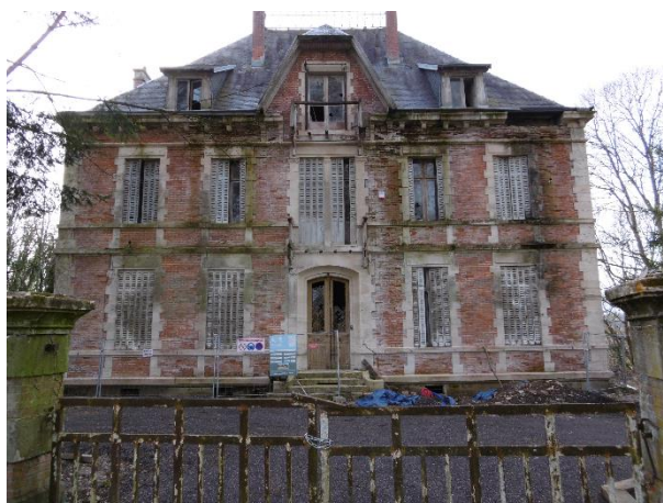
Point de vue n°10, le château du Petit-Bois au printemps 2023, avant sa démolition
