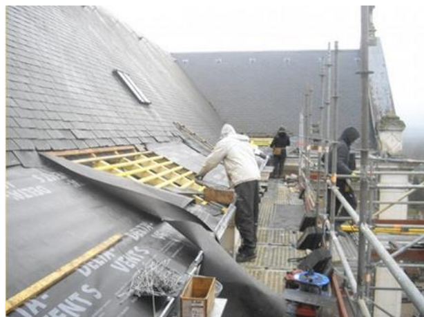
Réfection à neuf de la charpente et pose d'ardoises neuves ou récupérée
