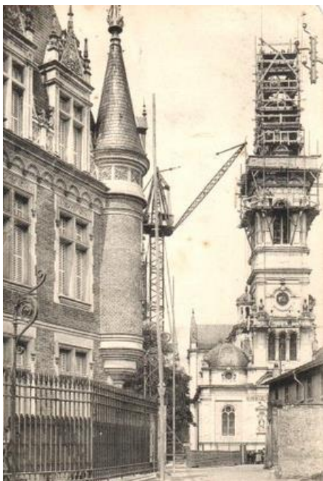
Carte postale du début du XX e siècle représentant l'église en travaux
