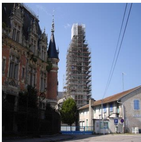
Août 2013 – Démarrage des travaux après mise en sécurité et échafaudage du chantier.
