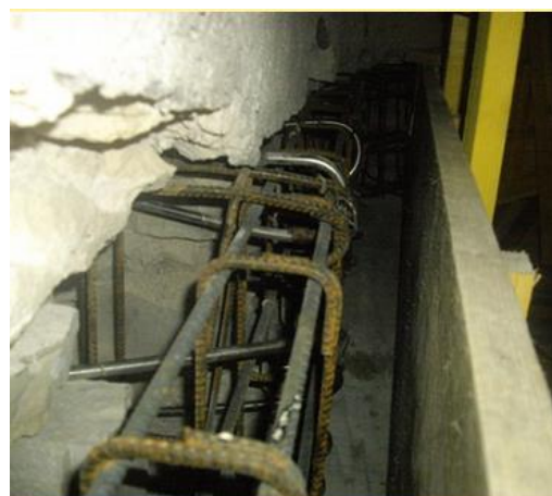
Travaux de confortement du clocher : 2.000 pierres de parement ont été solidarisées avec la maçonnerie par près de 7.000 agrafes. Les pierres de deux corniches sont retenues par deux anneaux en béton armé coulés à l'intérieur du clocher.
