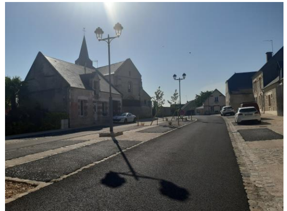
Stationnements aménagés Place de la Forge
