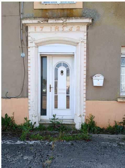
5. Linteau de porte supérieure principale du bâtiment au 10 rue Honoré de Balzac
