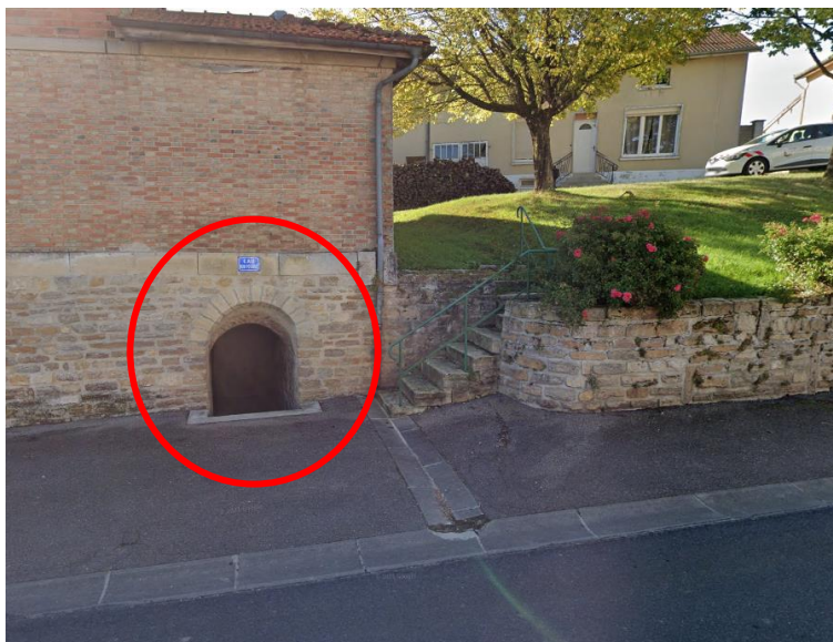
Figure 24 Localisation de l'arrivée d'eaux claires au niveau de la réserve d'eau
