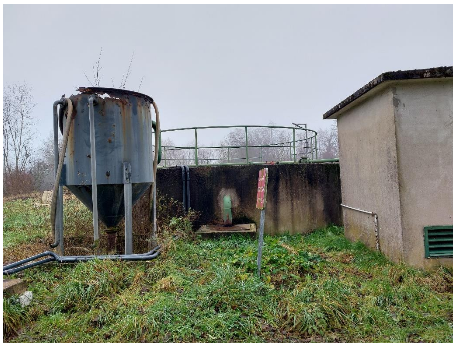
Figure 22 Vue sur le dessableur et le bassin d'aération de la station d'épuration existante
