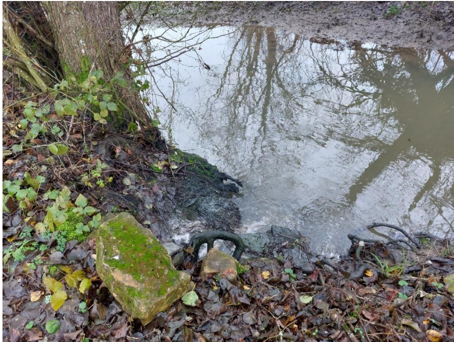
Figure 10 Vue sur La Bruxenelle à Cheminon au niveau du rejet de la station d'épuration
