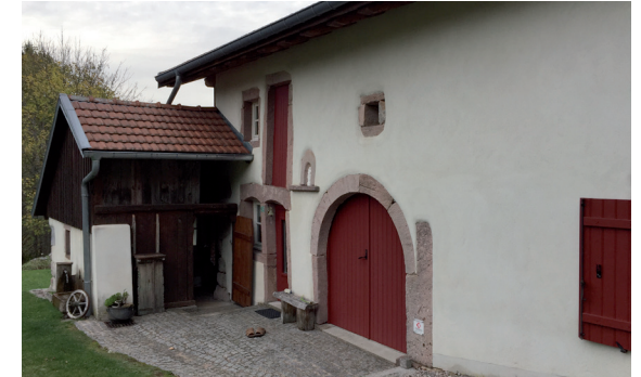
Très bel exemple d'une ferme restaurée à la Béotte
