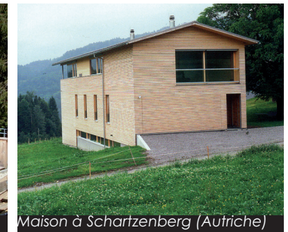
Ci-dessus : la maison posée à plat sur une terrasse induit des murs hauts et impactants (1) . La plate-forme pour la construction est plus intégrée au paysage lorsqu'elle est encastrée et que le talus aménagé s'accompagne de végétation (2) . Ci-dessous : le travail du terrain, en terrasses successives, assure une bonne implantation à la construction
