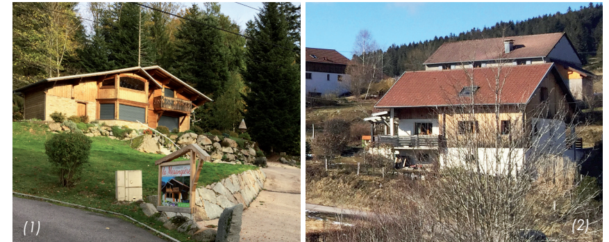
Ci-dessus : la maison posée à plat sur une terrasse induit des murs hauts et impactants (1) . La plate-forme pour la construction est plus intégrée au paysage lorsqu'elle est encastrée et que le talus aménagé s'accompagne de végétation (2) . Ci-dessous : le travail du terrain, en terrasses successives, assure une bonne implantation à la construction
