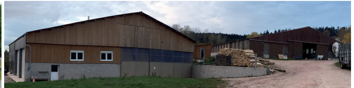
Le bardage bois, le décalage des bâtiments en suivant la pente et leurs inscription en déblai dans le terrain contribuent à la bonne intégration de l'exploitation (Gaec du Gd Liezey)
