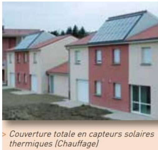
> Capteurs comme éléments à part entière de la composition architecturale (toiture de terrasse...)
