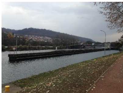
Ecluse de Pompey
