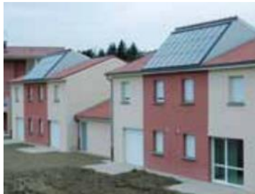
> Couverture totale en capteurs solaires thermiques (Chauffage)
