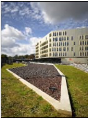
Massif d'infiltration à forte porosité
